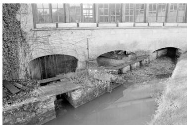
Voies d'eau. Phot. Benoît Dufournier IVR22_19946000186Z
