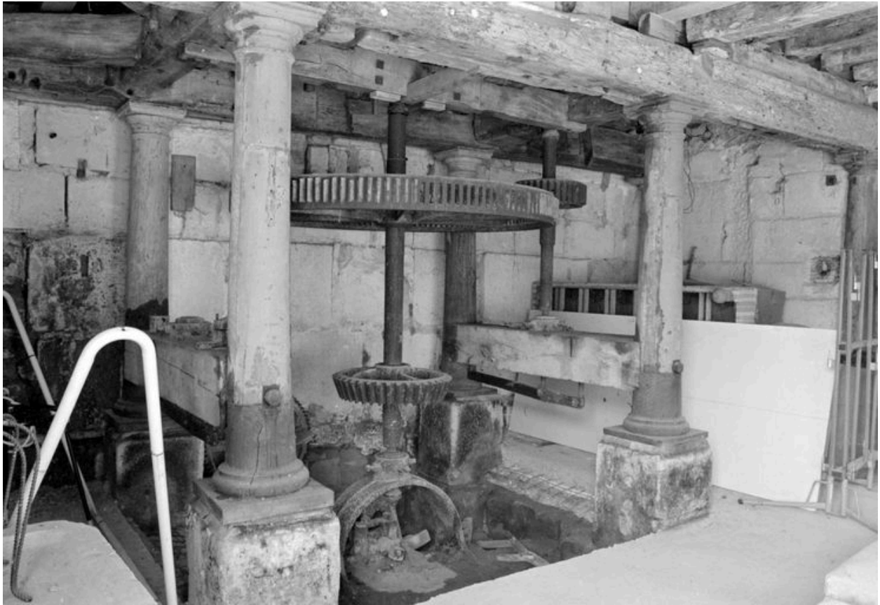
Beffroi, vue intérieure.
