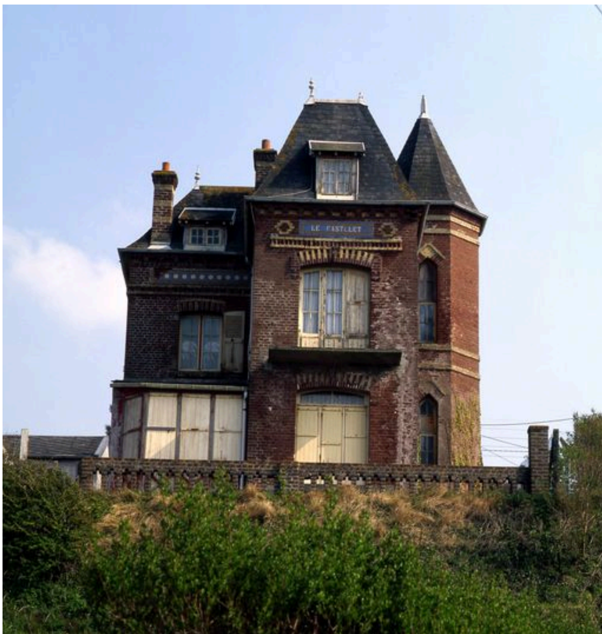
Vue d'ensemble, façade sur mer.
