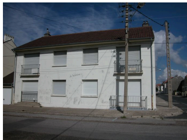
Vue d'ensemble, élévation antérieure. Phot. Elisabeth Justome IVR22_20058003807NUCA
