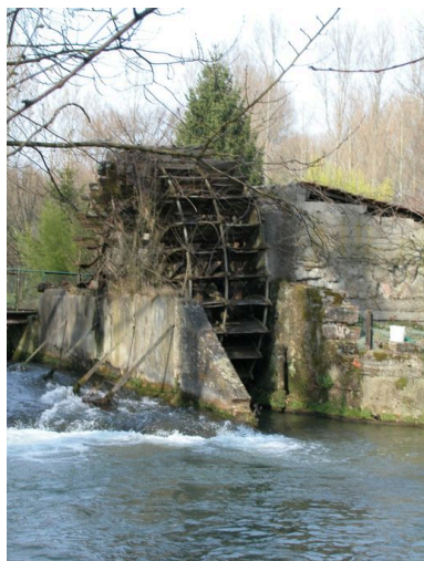
La roue du moulin dans sa coulerie. Phot. Thierry Lefébure IVR22_20036000180NUCA
