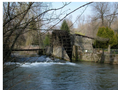
Vue d'ensemble de trois-quarts de la roue du moulin. Phot. Thierry Lefébure IVR22_20036000179NUCA
