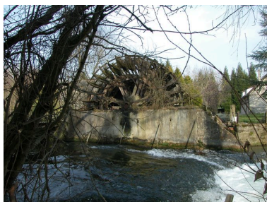
Vue d'ensemble de face de la roue du moulin et de sa coulerie. Phot. Thierry Lefébure IVR22_20036000181NUCA
