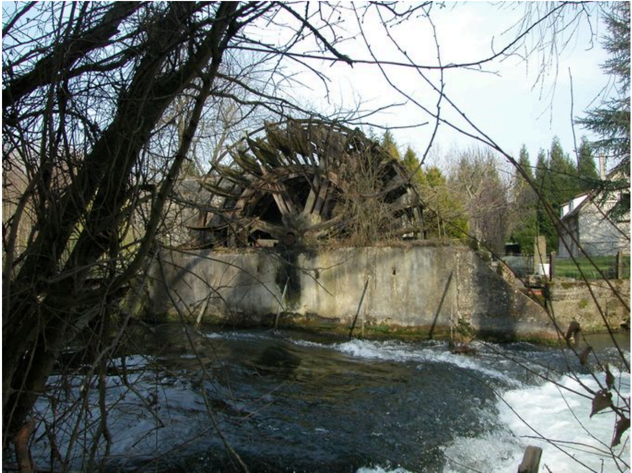
Vue d'ensemble de face de la roue du moulin et de sa coulerie.
