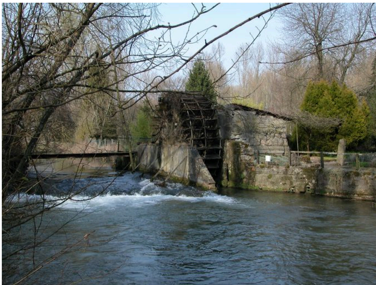
Vue d'ensemble de trois-quarts de la roue du moulin.
