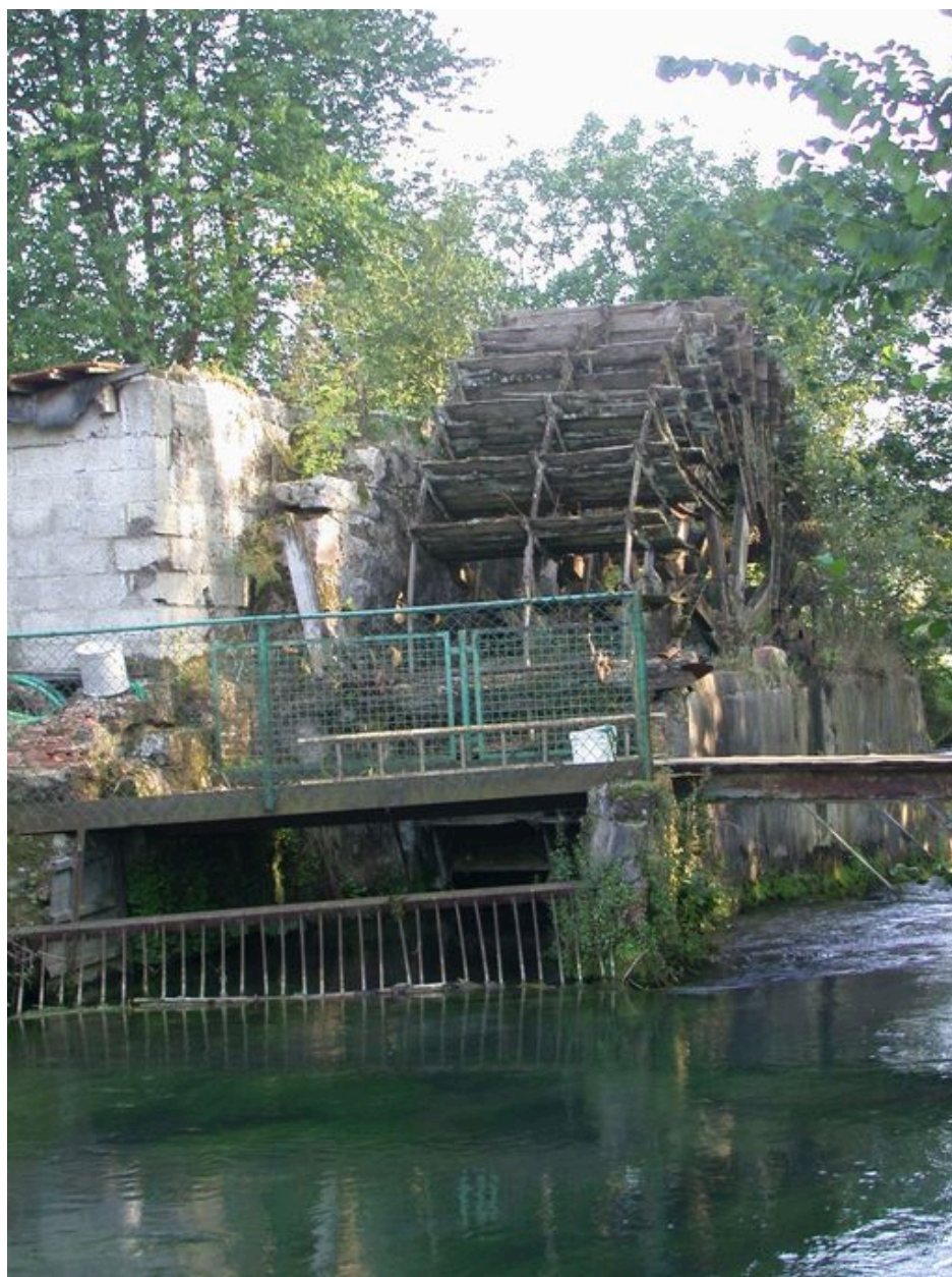
Vue des vestiges de la roue hydraulique.
