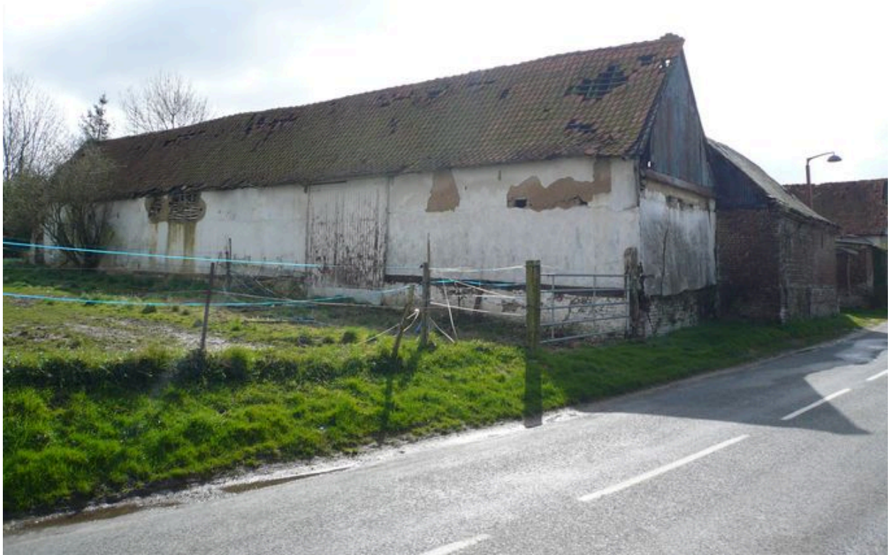
Vue postérieure de la grange depuis la pâture.
