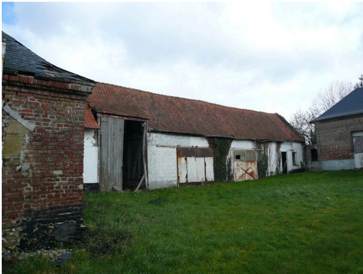
Vue de la grange au nord de la cour.
