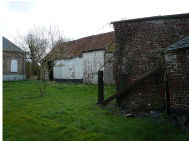
Vue de la grange située au sud de la cour. Phot. Inès Guérin IVR22_20078005602NUCA
