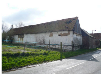
Vue postérieure de la grange depuis la pâture. Phot. Inès Guérin IVR22_20078005601NUCA
