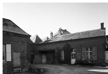
Le logement. Phot. Thierry Lefébure IVR22_19950203285V
