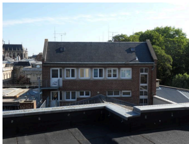
Vue du bâtiment des bureaux, à l'arrière de la salle de conférence. Phot. Isabelle Barbedor IVR22_20118010015NUCA
