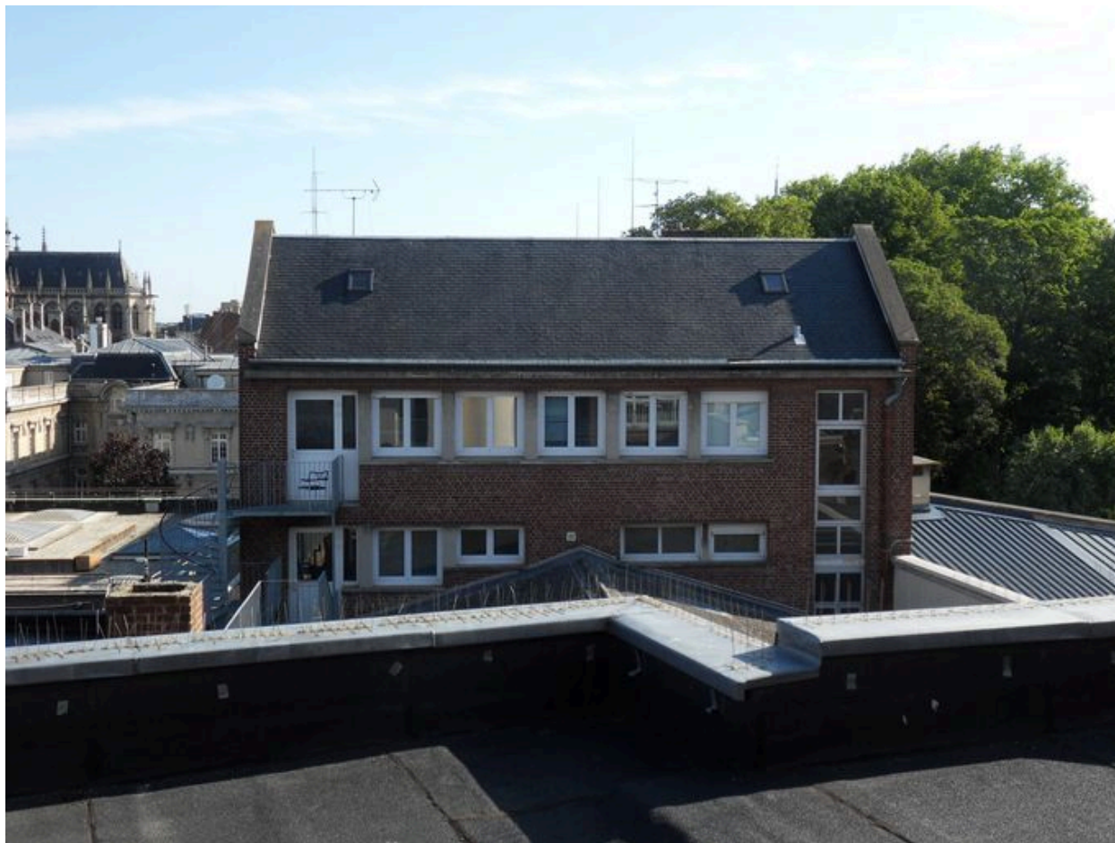
Vue du bâtiment des bureaux, à l'arrière de la salle de conférence.
