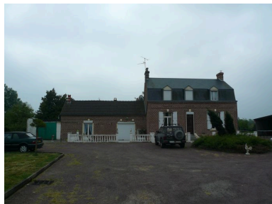
Vue générale. Phot. Inès Guérin IVR22_20078005841NUCA
