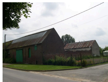
Ferme, rue de Querrieu. Phot. Isabelle Barbedor IVR22_20068010284NUCA
