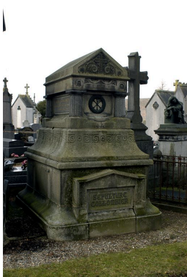
Vue générale, depuis le sud-ouest. Phot. Thierry Lefébure IVR22_20058000222NUCA
