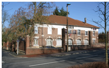
Immeuble de logements collectifs. Phot. Frédéric Pillet IVR22_20060205233NUCA
