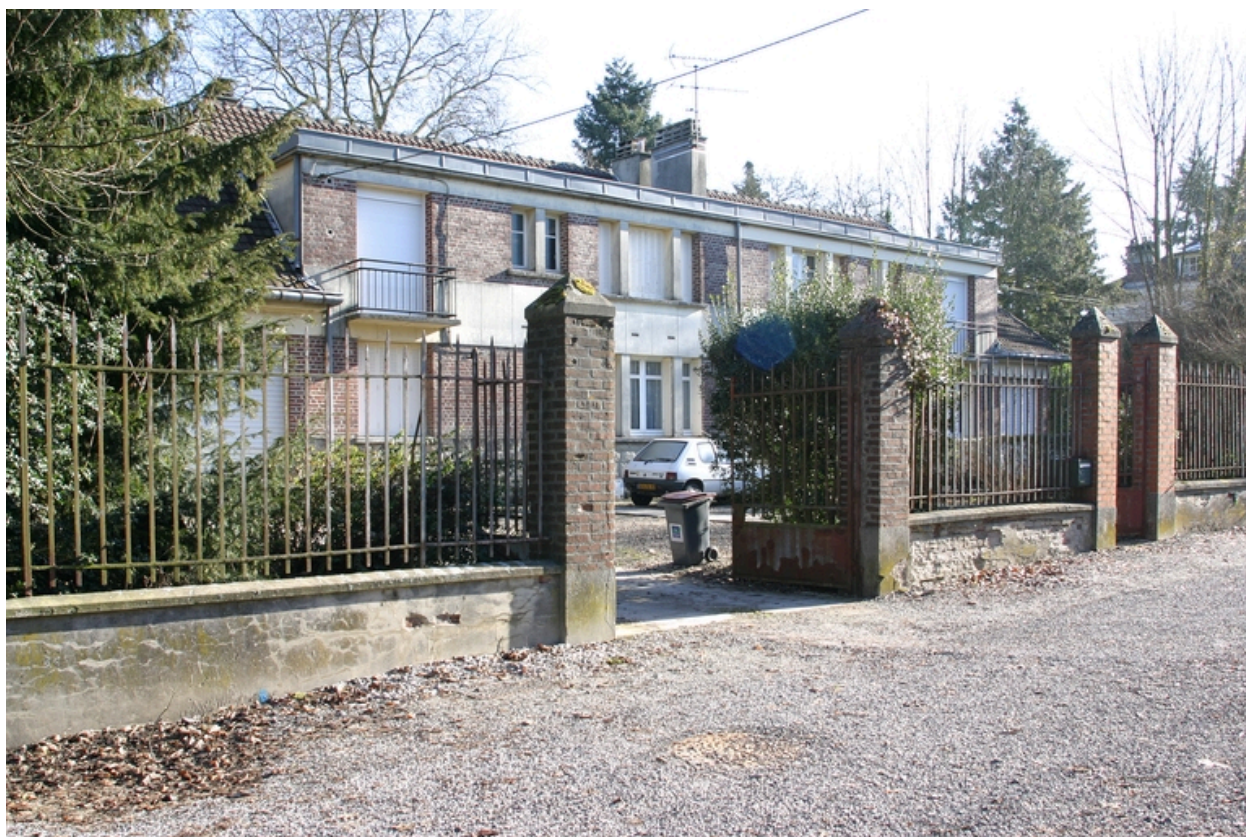
Bâtiment à deux logements de 1940.
