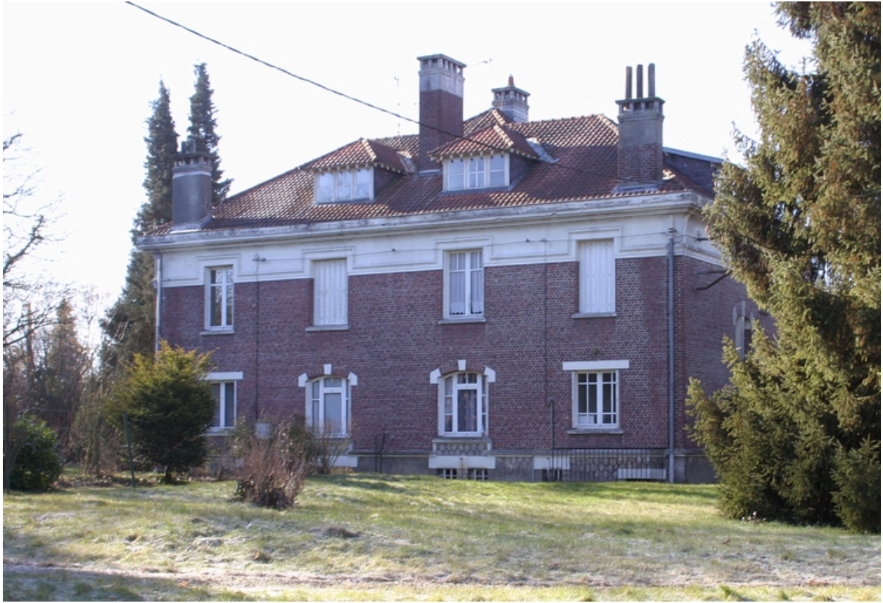
Bâtiment à deux logements de 1926-1928, façade postérieure.
