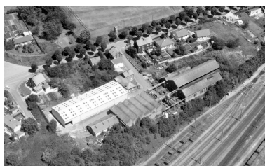
Vue aérienne, flanc sud-ouest. Phot. Phot'R IVR22_19888001223P
