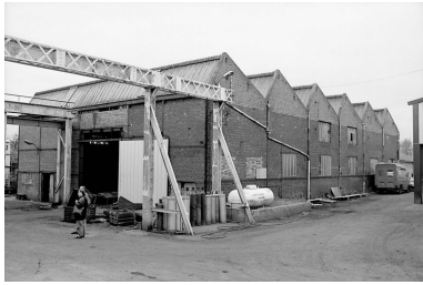
Atelier de fabrication 2, flanc nord-ouest. Phot. Francis Dubuc IVR22_19908000996Z
