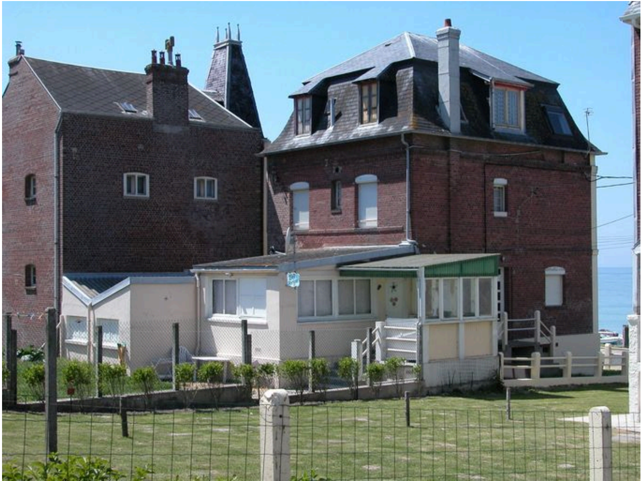
Vue de trois-quarts sur la façade postérieure.
