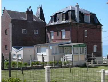
Vue de trois-quarts sur la façade postérieure. Phot. Elisabeth Justome IVR22_20058003290NUCA
