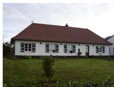
Maison, 31 rue du Haut, 1er quart 20e siècle (1984 B 567, 569). Phot. Inès Guérin IVR22_20068005495NUCA
