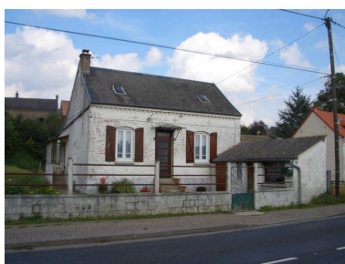
Ancienne maison de serrurier, 21 rue de la Baie, fin 19e siècle (1984 B 421). Phot. Inès Guérin IVR22_20068005482NUCA
