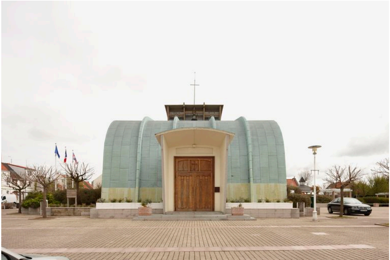
Vue générale de la façade.
