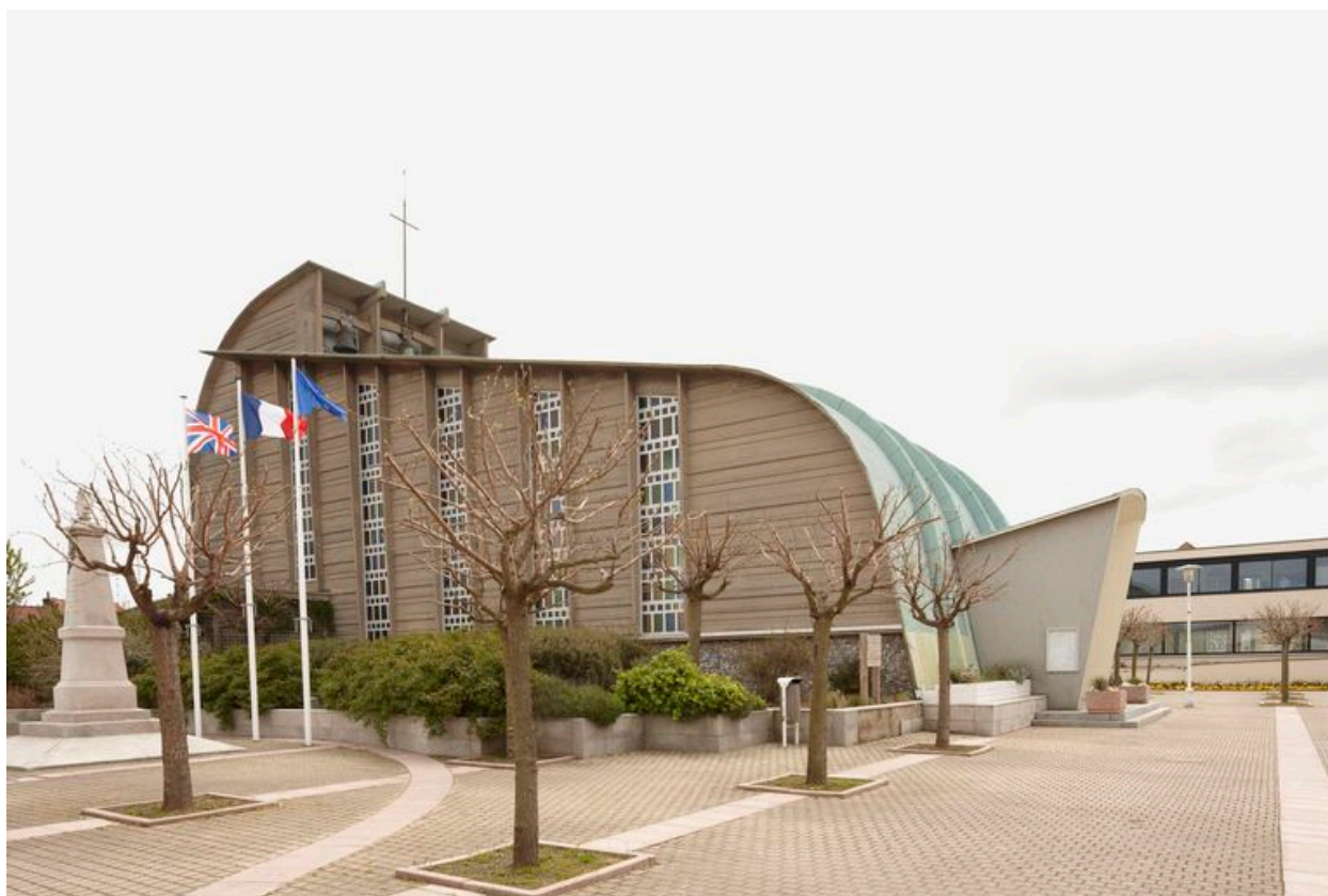
Vue générale de l'élévation latérale.
