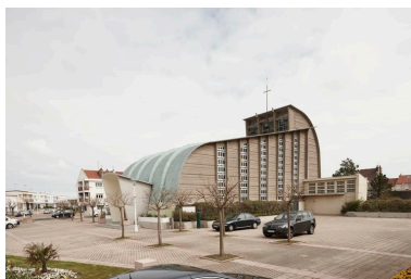
Vue de l'élévation latérale. Phot. Hubert Bouvet IVR31_20106200654NUCA
