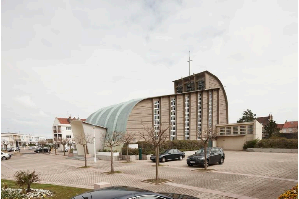
Vue de l'élévation latérale.
