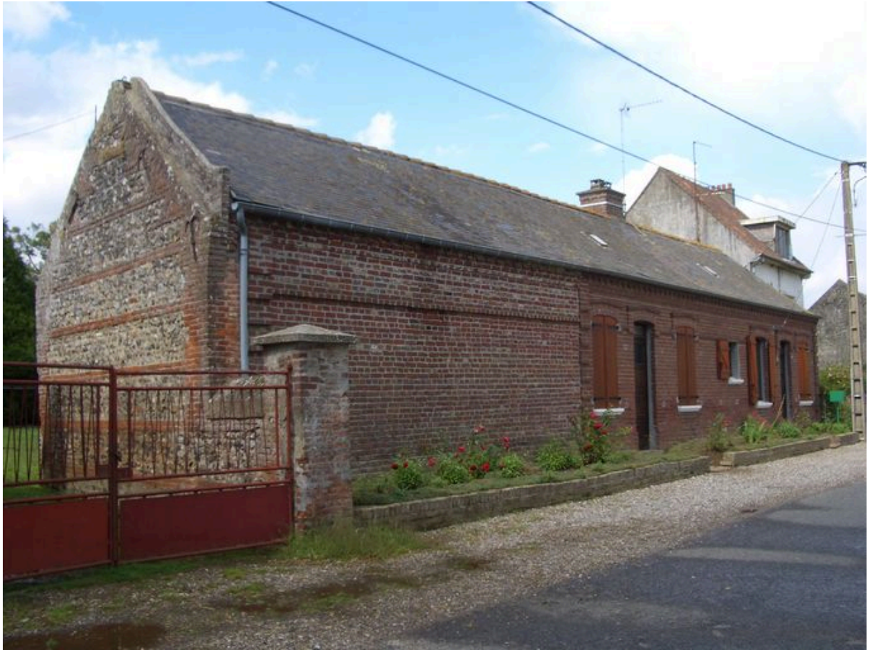
Vue du logis sur rue.
