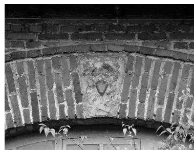
Clé avec armoiries sur l'arc du passage traversant de l'ancienne grange. Phot. Philippe Dapvril IVR31_20045900664X
