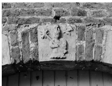
La clé du portail portant les armoiries. Phot. Philippe Dapvril IVR31_20045900688X
