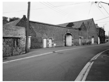
Presbytère, 95, rue Alexandre-Dubois, vue générale. Phot. Philippe Dapvril IVR31_20045900690X
