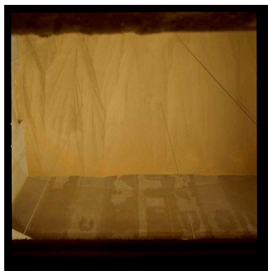
Vue plongeante sur l'une des cellules de stockage à demie remplie de grains. Phot. Thierry Lefébure IVR22_20106000654XA
