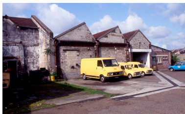
Ateliers couverts en sheds en 1992. Phot. Benoît Dufournier IVR22_19926000012ZA
