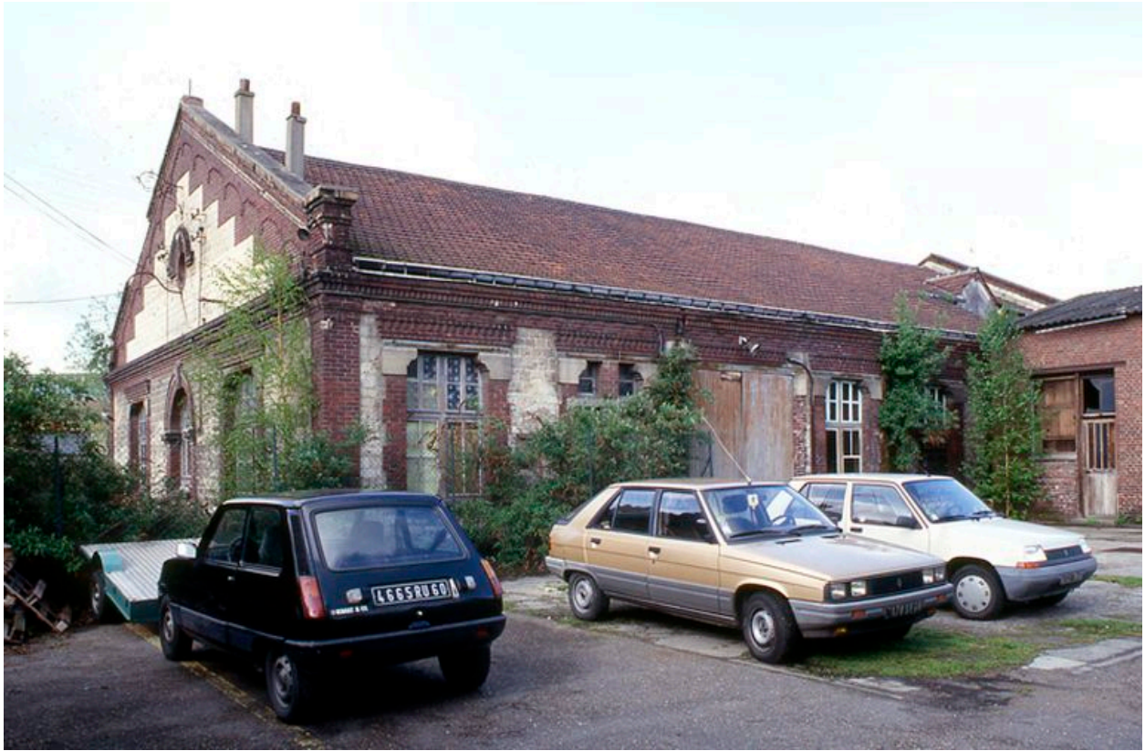
Façade est de l'atelier en 1992.
