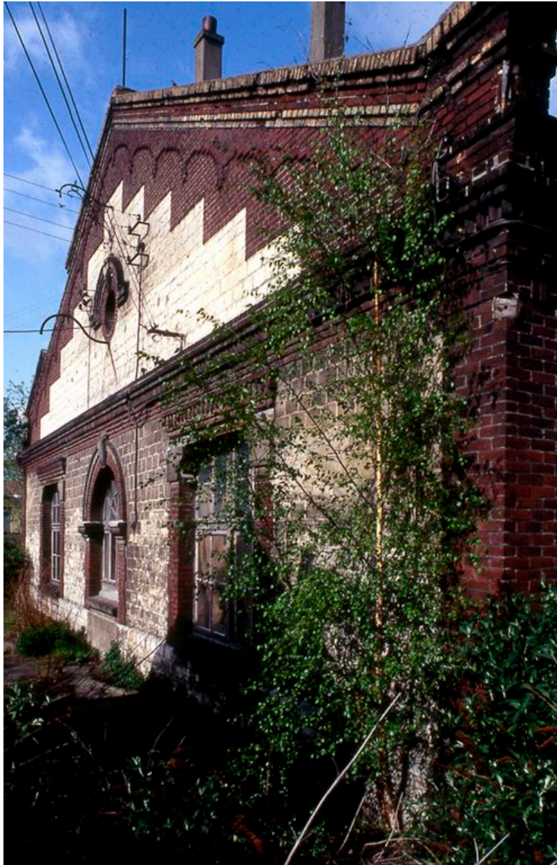
Détail du mur pignon de l'atelier en 1992.
