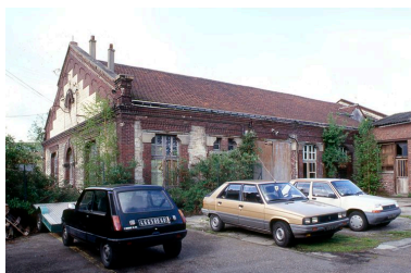
Façade est de l'atelier en 1992. Phot. Benoît Dufournier IVR22_19926000011ZA
