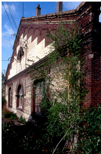
Détail du mur pignon de l'atelier en 1992. Phot. Benoît Dufournier IVR22_19926000014ZA
