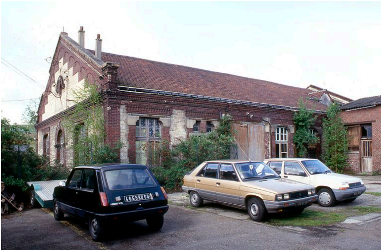
Façade est de l'atelier en 1992.
