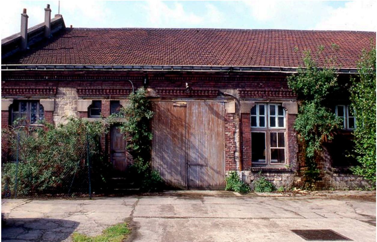
Détail des travées des ateliers.
