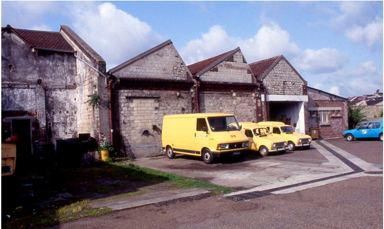
Ateliers couverts en sheds en 1992.
