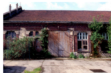
Détail des travées des ateliers. Phot. Benoît Dufournier IVR22_19926000013ZA
