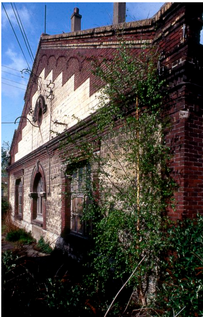
Détail du mur pignon de l'atelier en 1992.
