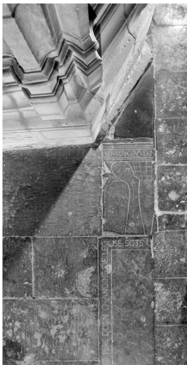
Elément de la dalle. Phot. Thierry Lefébure IVR22_19980200576X
