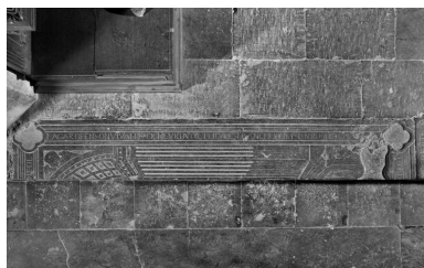
Elément de la dalle. Phot. Thierry Lefébure IVR22_19980200574X
