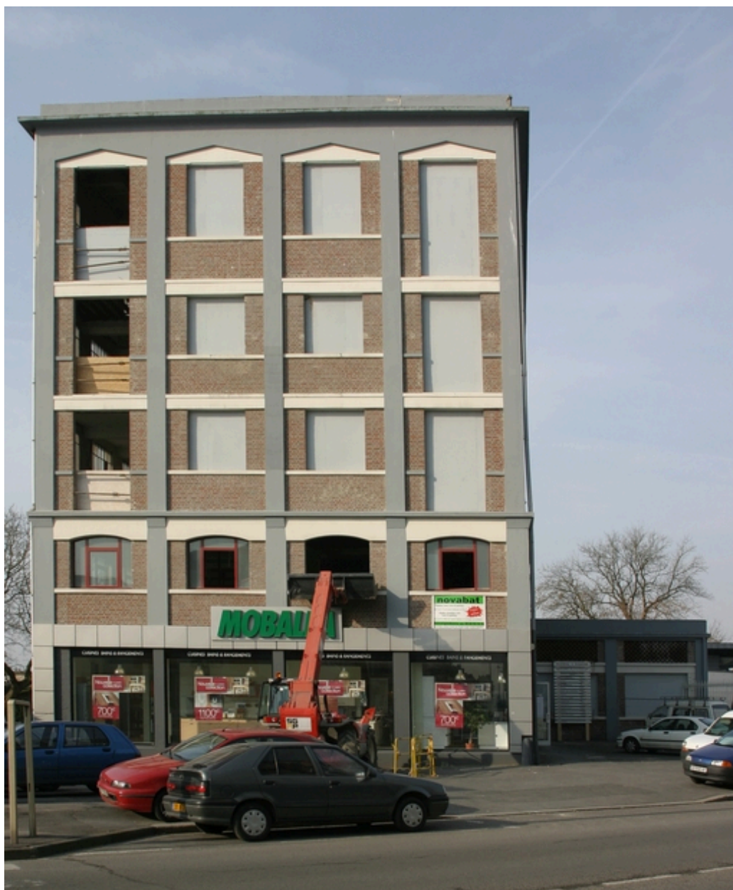
Façade est de la minoterie.
