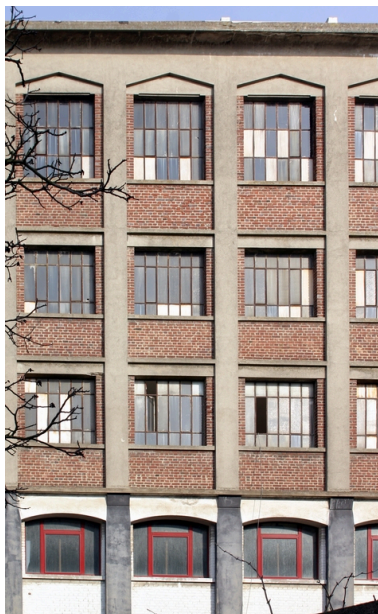
Détail de la façade sud. Phot. Frédéric Pillet IVR22_20050205322NUCA
