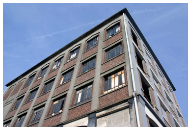
Angle sud-est de la minoterie. Phot. Frédéric Pillet IVR22_20050205321NUCA
