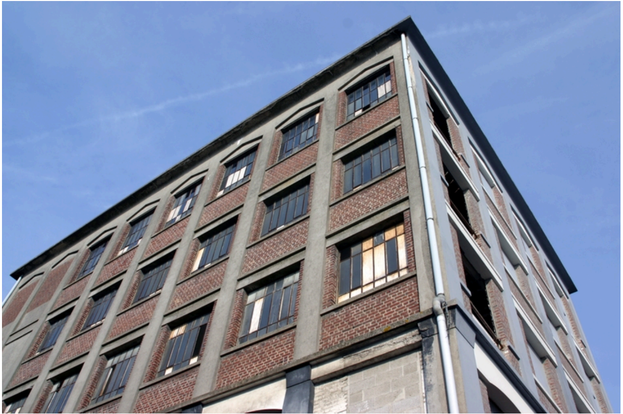
Angle sud-est de la minoterie.
