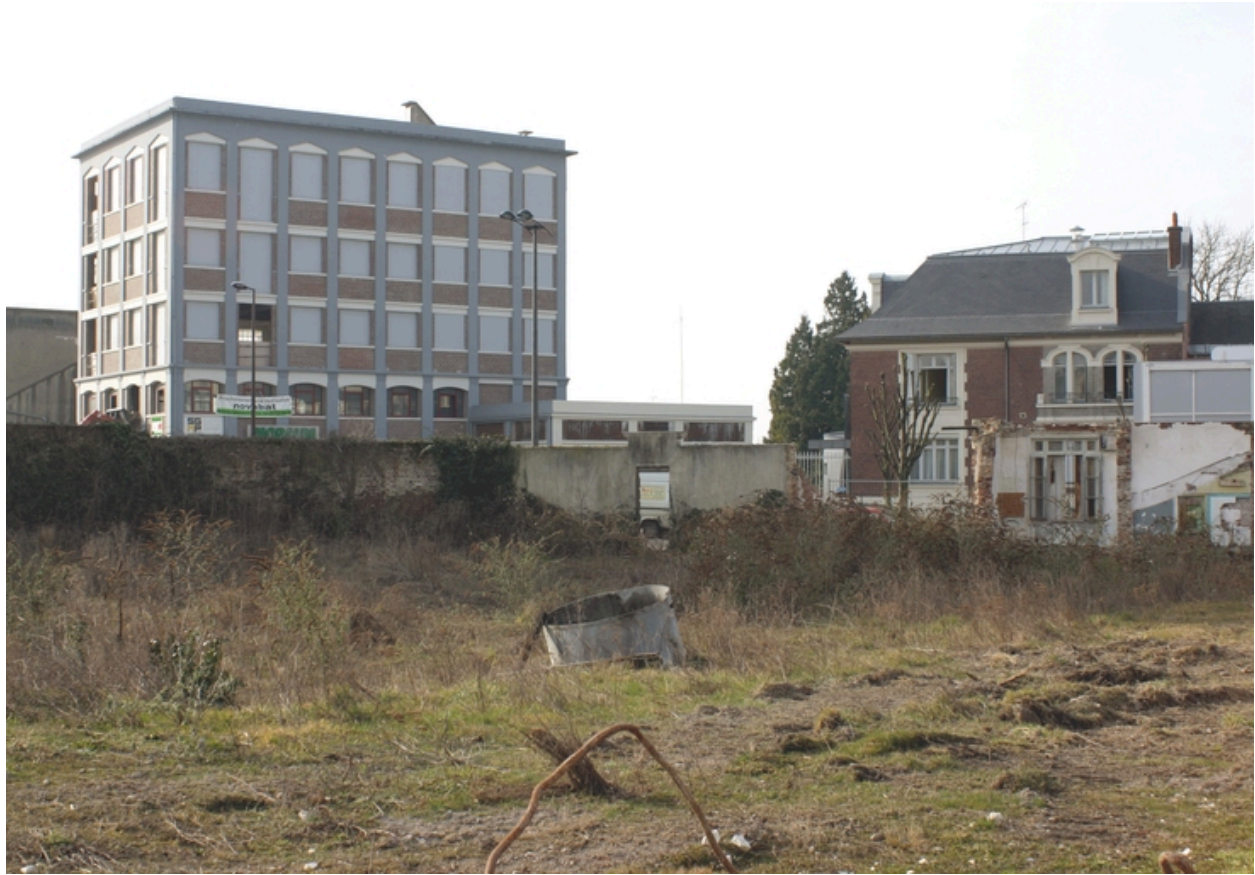
La minoterie et le logement patronal, vus depuis la friche industrielle de l'ancien tissage Tourn.
