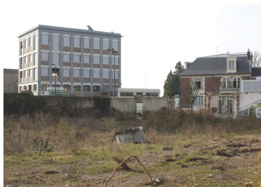
La minoterie et le logement patronal, vus depuis la friche industrielle de l'ancien tissage Touron. Phot. Frédéric Pillet IVR22_20050205318NUCA
