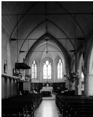
Vue intérieure vers le chœur. Phot. Jean-Michel Perrin IVR22_19846000981V
