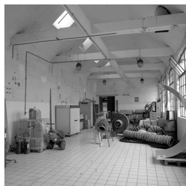
Intérieur de l'atelier de fabrication. Phot. Thierry Lefébure IVR22_19986000097X
