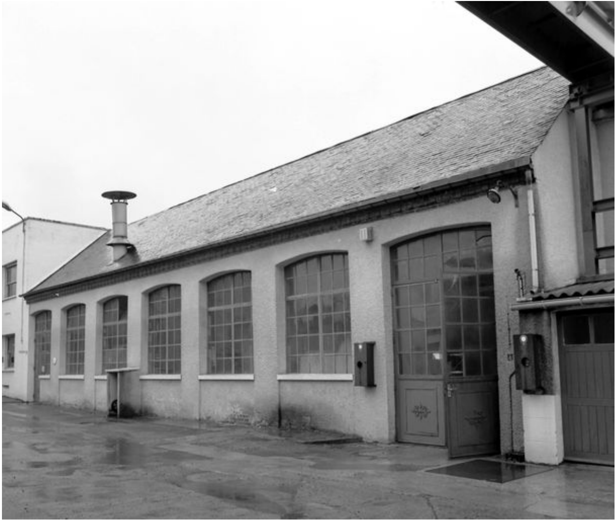
L'atelier de fabrication, façade est sur cour.
