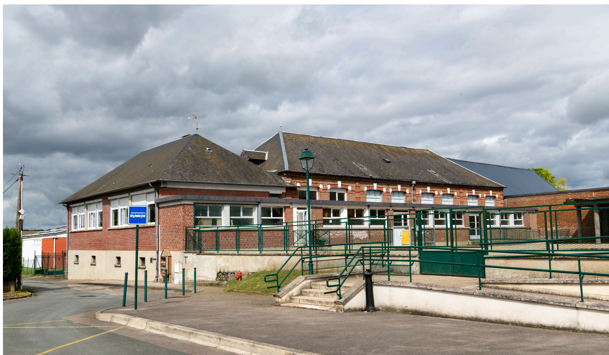
École, vue depuis le sud.
