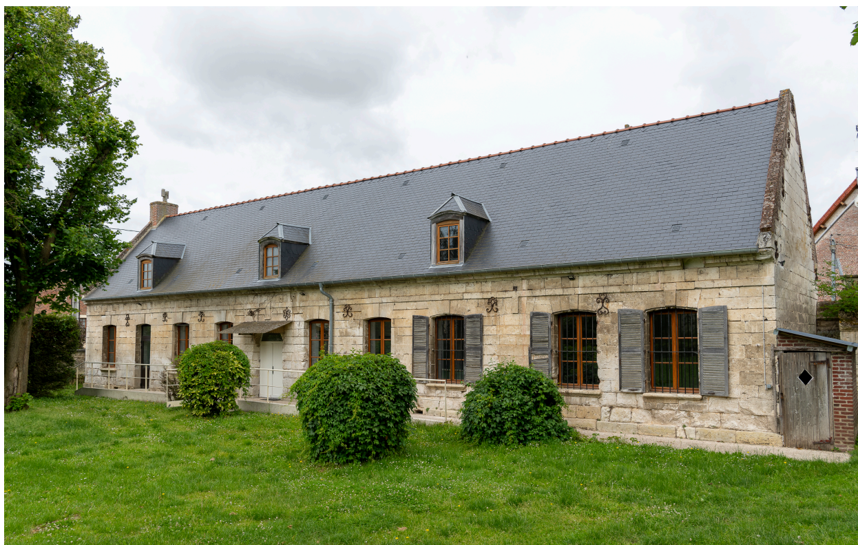
Ancien presbytère, vue depuis la cour intérieure (côté sud).
