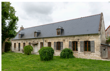
Ancien presbytère, vue depuis la cour intérieure (côté sud). Phot. Marc Kérignard IVR32_20246000687NUCA
