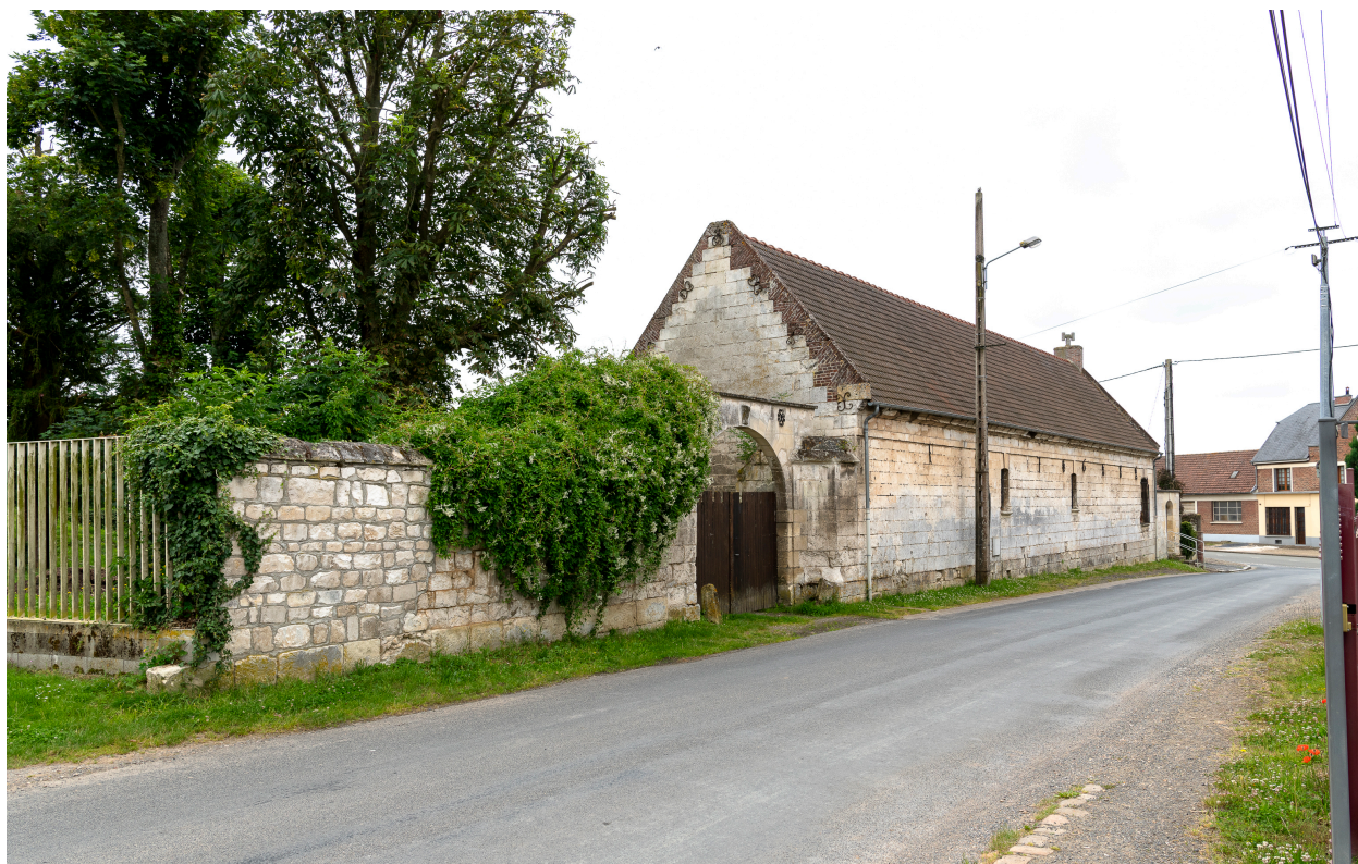
Ancien presbytère avec son porche d'entrée, route de Paillart, vue depuis le nord.
