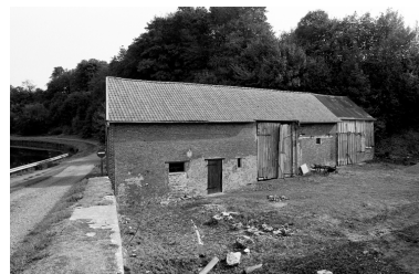
Vue ouest de la grange et de l'étable. Phot. Christiane Riboulleau IVR22_19940201460Z
