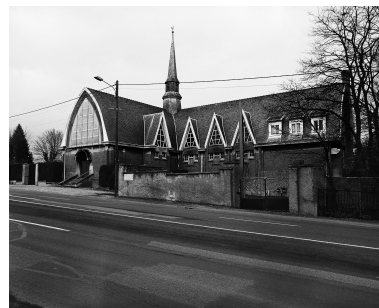
Vue générale du couvent depuis la rue. Phot. Thierry Petitberghien IVR31_20025900373X
