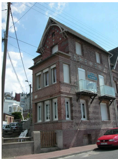
Vue depuis la rue de la Plage, façade sur mer. Phot. Elisabeth Justome IVR22_20058003014NUCA
