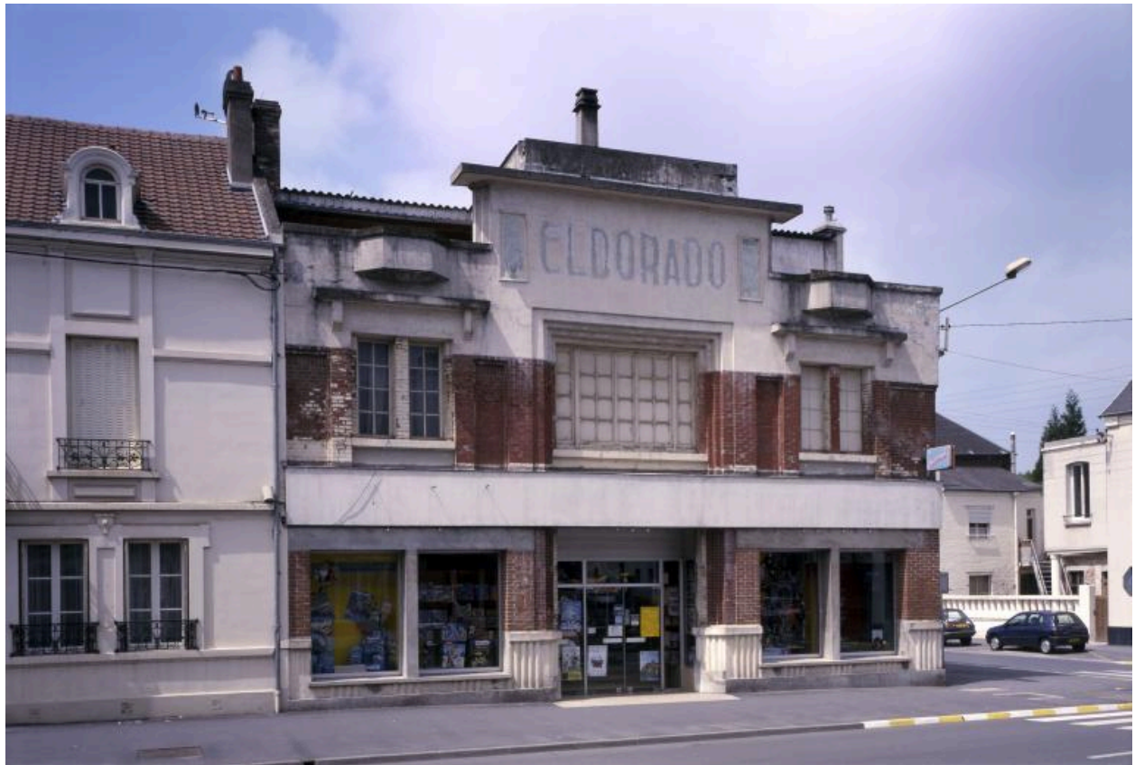
Vue de la façade sur rue de l'ancien cinéma.
