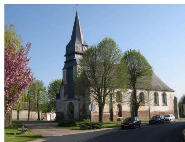
Vue générale, depuis le sud-ouest. Phot. Isabelle Barbedor IVR22_20078012015NUCA
