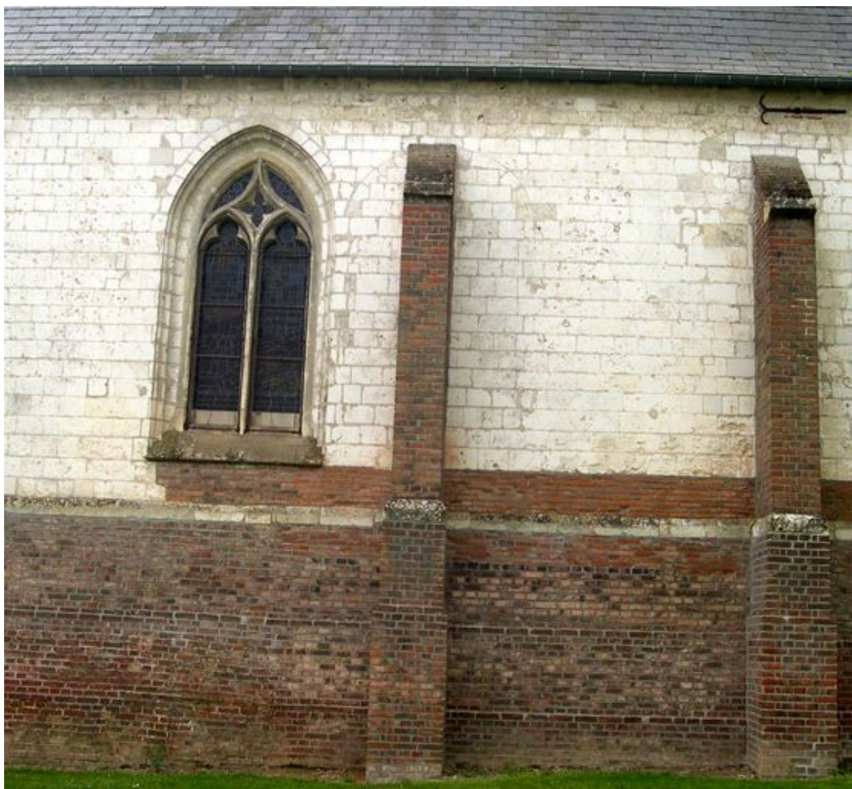
Baie murée du mur nord.
