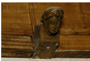
Vue intérieure : détail d'un blochet de la nef. Phot. Thierry Lefébure IVR22_20078000025NUCA
