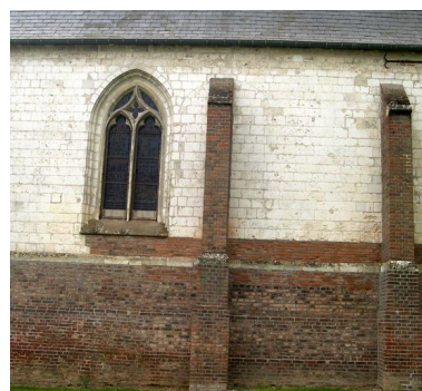
Baie murée du mur nord. Phot. Isabelle Barbedor IVR22_20078012019NUCA
