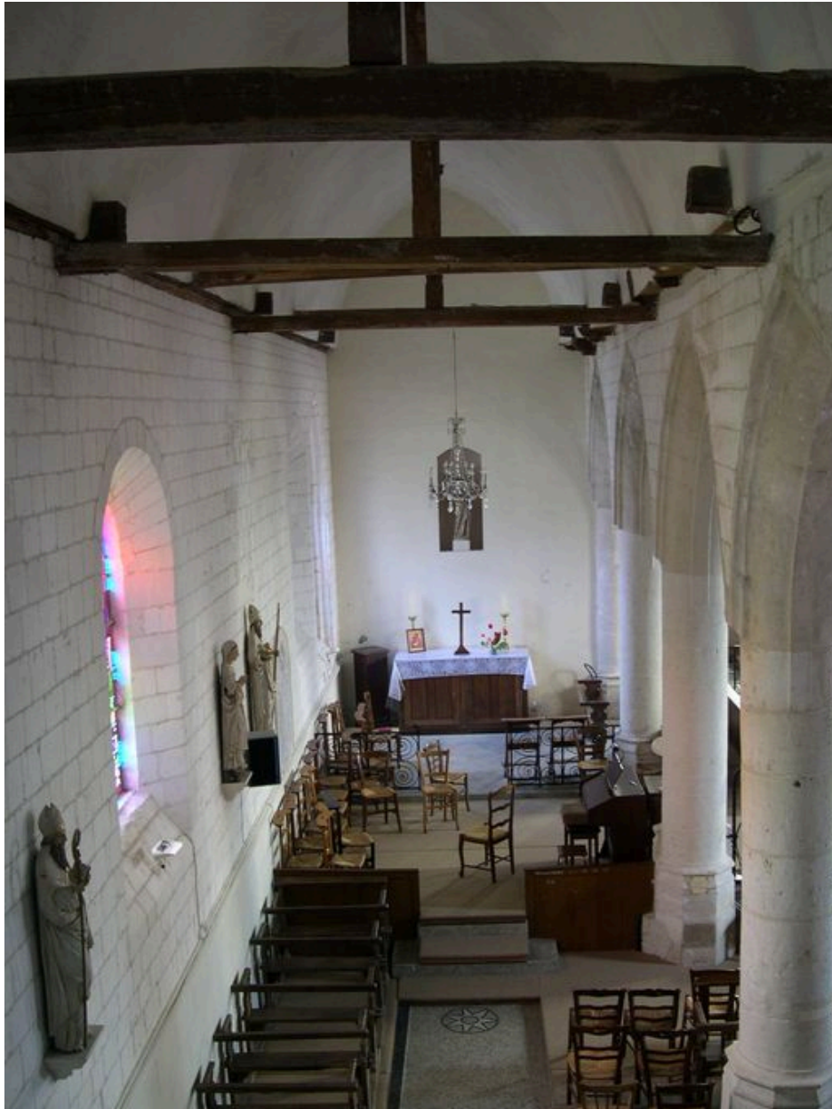
Vue intérieure du bas-côté nord.
