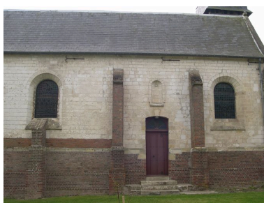
Porte du bas-côté nord. Phot. Isabelle Barbedor IVR22_20078012018NUCA
