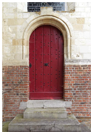
Porte sud de la nef. Phot. Marie-Laure Monnehay-Vulliet IVR22_20138000465NUC2A
