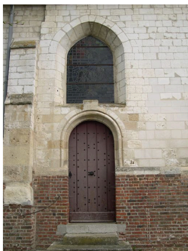
Porte sud de la nef. Phot. Isabelle Barbedor IVR22_20078012020NUCA
