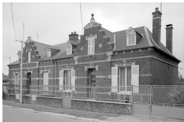
Elévation antérieure. Phot. Jean-Michel Perrin IVR22_19856000948X
