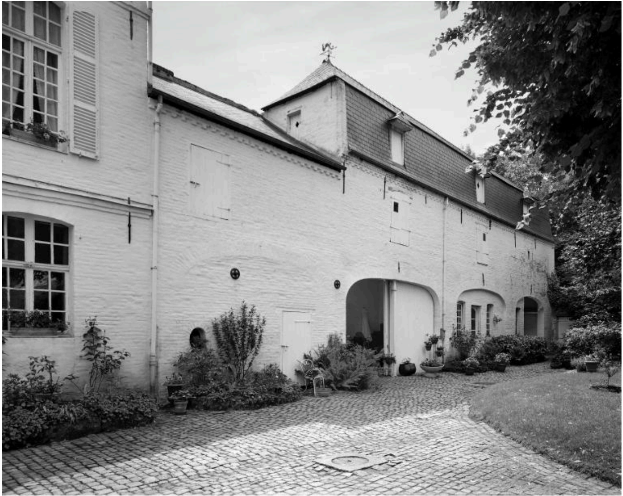
Vue de l'aile, en retour d'équerre sur cour, de logis principal, prolongée par le corps de bâtiment des communs comprenant un fournil, une remise, un cabinet de bains et une buanderie.
