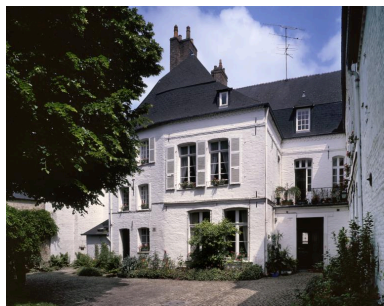
Vue de la façade sur cour du corps de logis principal et de la maison annexe à gauche.
