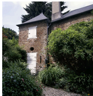
Vue de la petite écurie bâtie sur le côté droit de la cour.
