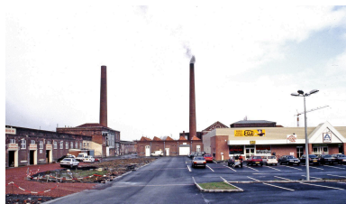
Vue générale vers l'est prise depuis l'entrée. Phot. Olivier Marlard IVR31_19985900268ZA
