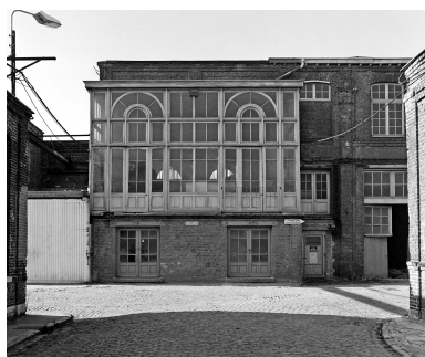
Salle des machines. Élévation antérieure. Phot. Olivier Marlard IVR31_19905901057X
