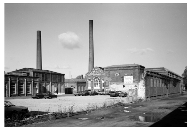
Vue générale prise vers le nord-ouest. À gauche le crémage et au centre une salle des machines. Phot. Olivier Marlard IVR31_19905900964X
