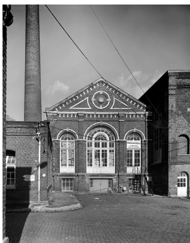
Seconde salle des machines. Élévation antérieure. Phot. Olivier Marlard IVR31_19905900960X
