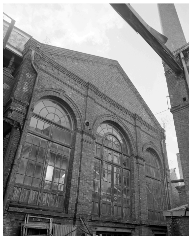
Seconde salle des machines. Élévation postérieure. Phot. Olivier Marlard IVR31_19905900968X
