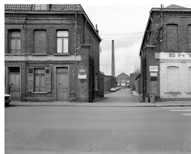
Vue générale depuis la rue. Vue prise vers le nord. Phot. Philippe Caudroit IVR31_19805900014X
