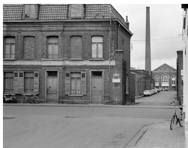
Vue générale depuis la rue. Vue prise vers le nord. Phot. Philippe Caudroit IVR31_19805900028X
