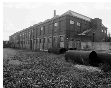
Magasin, enfilade. Vue prise vers le sud. Phot. Olivier Marlard IVR31_19905900971X
