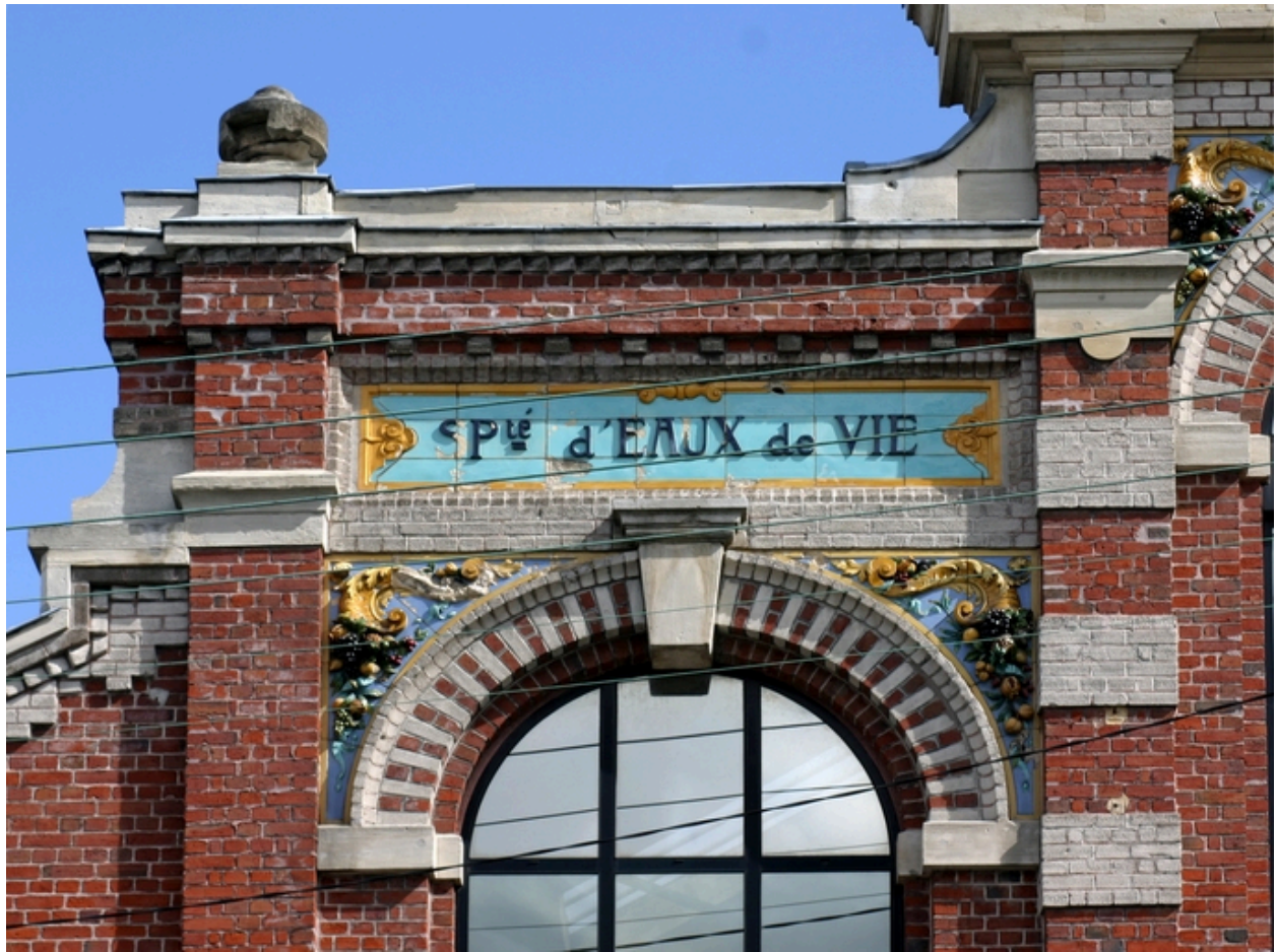
Façade antérieure, détail.
