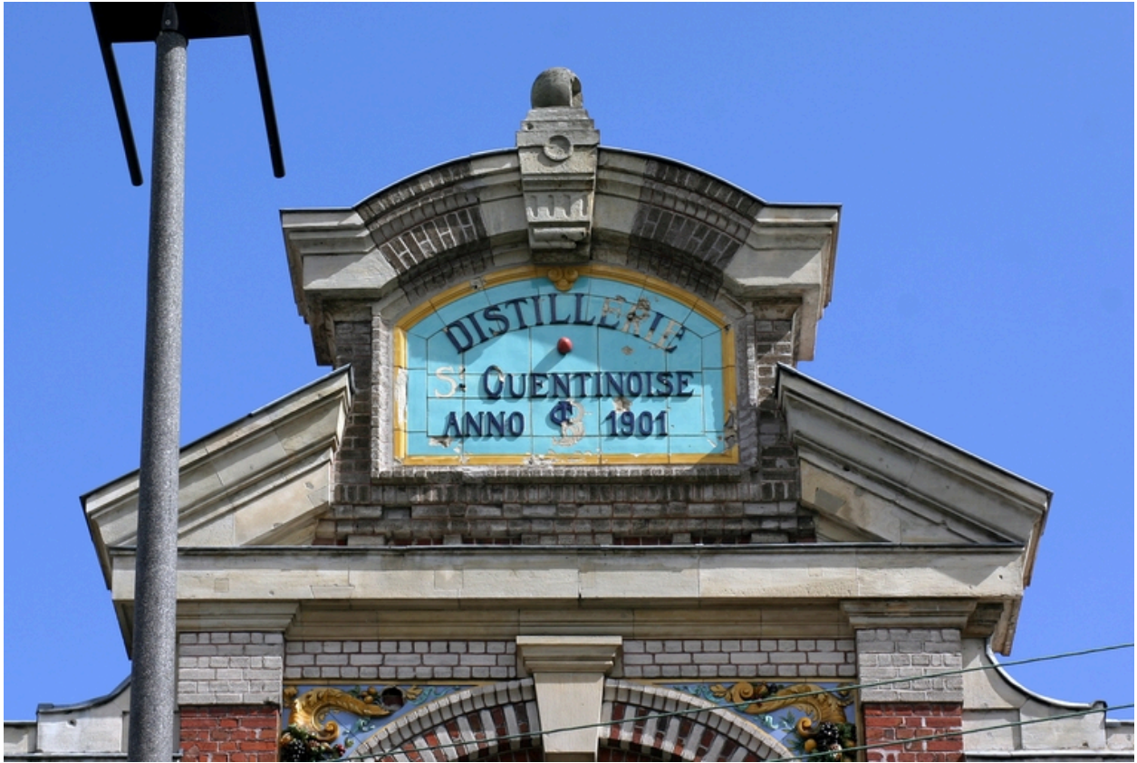
Façade antérieure, détail.
