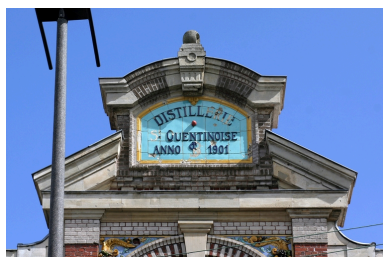
Façade antérieure, détail. Phot. Frédéric Pillet IVR22_20050206010NUCA
