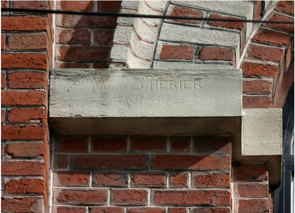
Détail de la façade antérieure : inscription du nom de l'architecte.
