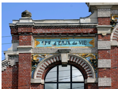
Façade antérieure, détail. Phot. Frédéric Pillet IVR22_20050206011NUCA
