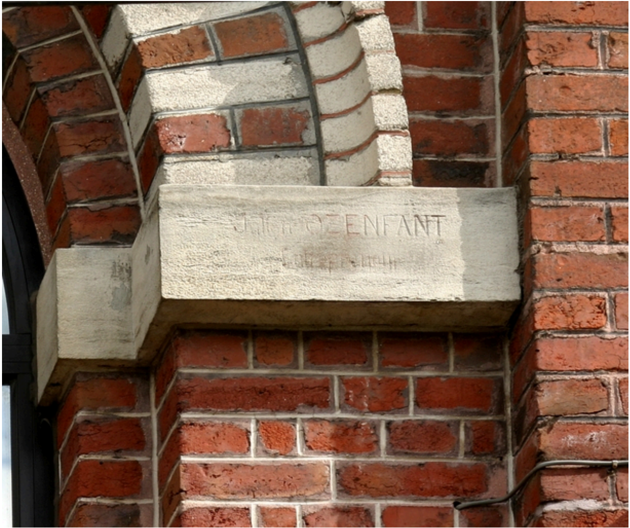
Détail de la façade antérieure : inscription du nom de l'entrepreneur.
