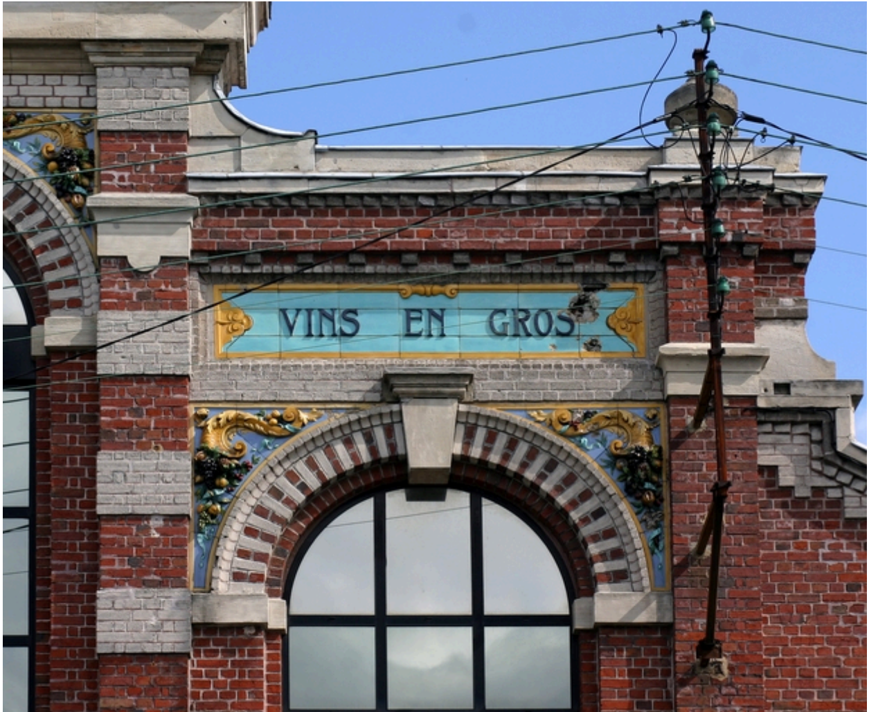
Façade antérieure, détail.
