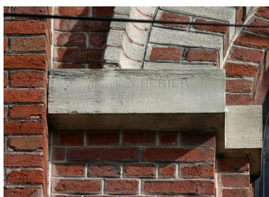
Détail de la façade antérieure : inscription du nom de l'architecte. Phot. Frédéric Pillet IVR22_20050206014NUCA
