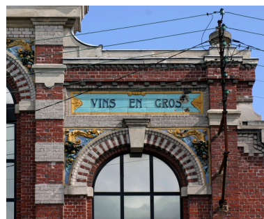
Façade antérieure, détail. Phot. Frédéric Pillet IVR22_20050206012NUCA
