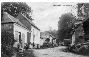
Havernas - Rue d'Amiens, avant 1911 (coll. part.). Les bâtiments apparaissent à gauche de l'image. Phot. Monnehay-Vulliet Marie-Laure IVR22_20108000385NUCA
