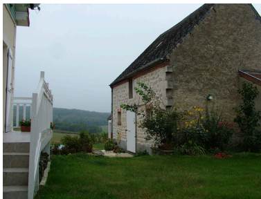
Vue de la dépendance agricole. Phot. Irwin Leullier IVR22_20050201035NUCA
