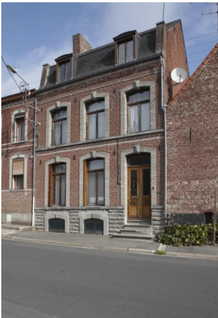
Vue générale de la maison située 103 rue Barbeau.
