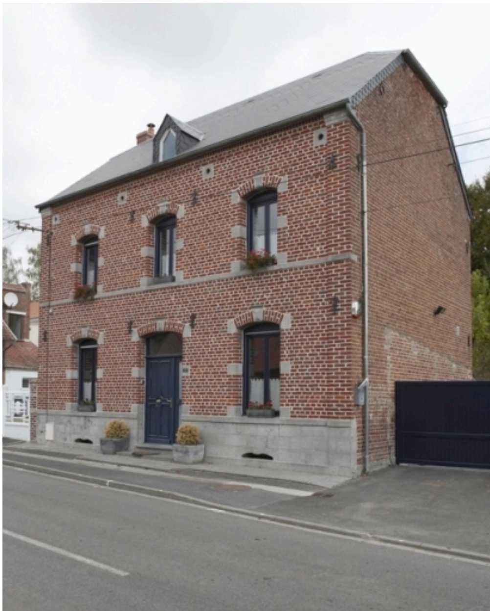
Vue générale de la maison située 376 rue du Centre.
