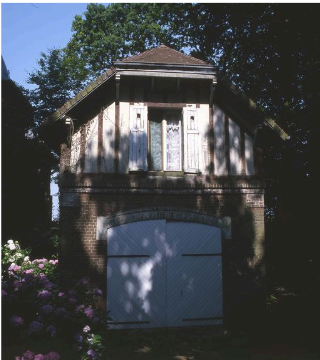
Vue de l'ancien garage à automobile (porte fermée).
