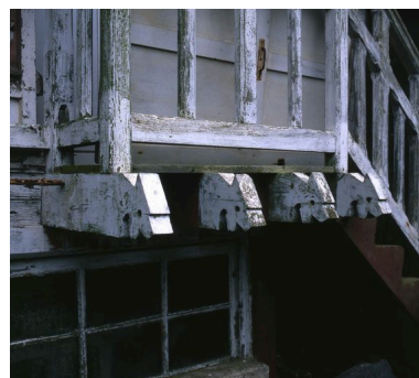
Détail des menuiseries extérieures.
