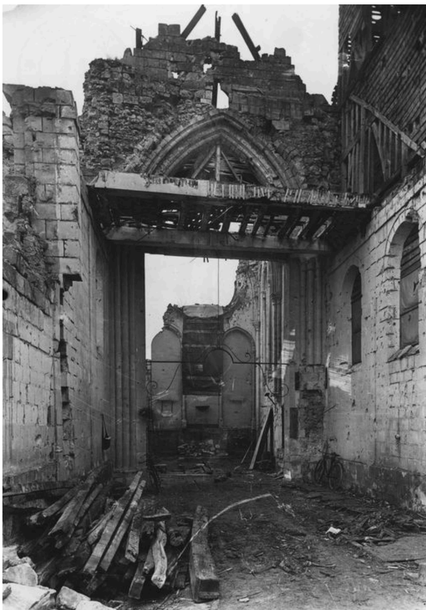
Nef, vue d'ouest en est. Etat en 1918 (Médiathèque du patrimoine ; cl. MH 23659).
