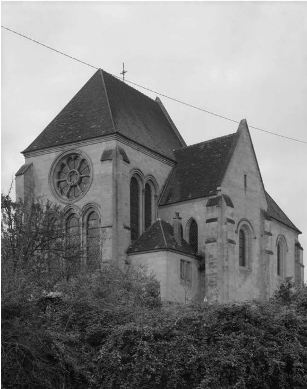
Vue générale nord-est.
