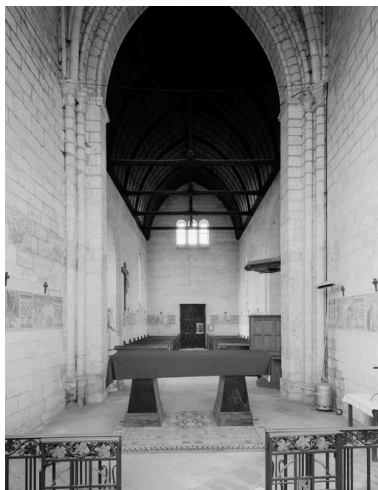
Vue intérieure vers l'entrée. Phot. Jean-Michel Perrin IVR22_19846001299V
