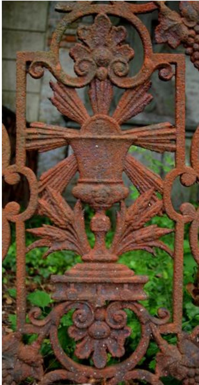
Détail du décor du vantail central de la grille de clôture.
