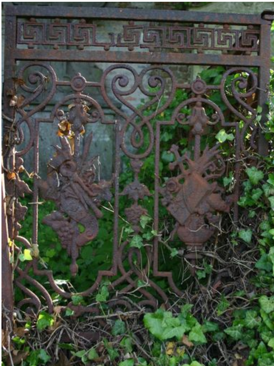
Vantail droit de la grille de clôture.
