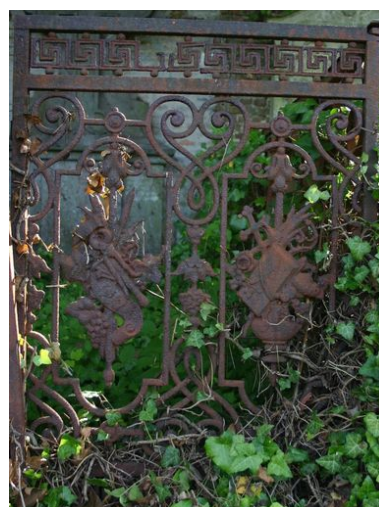
Vantail droit de la grille de clôture.
