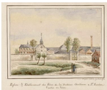
La chapelle en 1870. Aquarelle de Macqueron (BM Abbeville ; Bov. 84). Phot. Bibliothèque municipale d'Abbeville IVR32_20168006466NUCA
