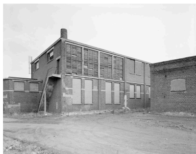
Magasin des toiles, atelier de fabrication, vers l'est. Phot. Olivier Marlard IVR31_19905901079V
