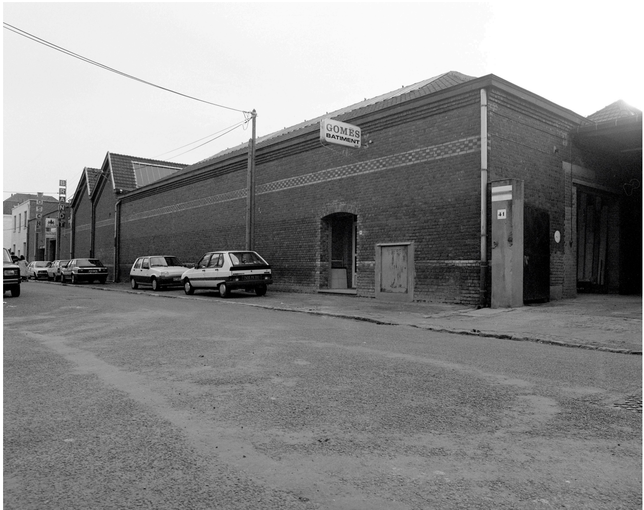
Élévation rue Voltaire, vers le sud.
