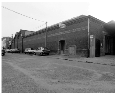
Élévation rue Voltaire, vers le sud. Phot. Olivier Marlard IVR31_19905901053X
