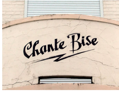
Détail de l'appellation peinte sur un des balcons. Phot. Elisabeth Justome IVR22_20058002949NUCA
