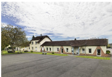
Vue générale depuis le nord-est. Phot. Thierry Lefébure IVR32_20170200186NUC2A
