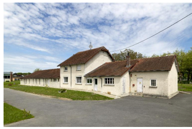
Vue générale depuis le sud-ouest. Phot. Thierry Lefébure IVR32_20170200184NUC2A
