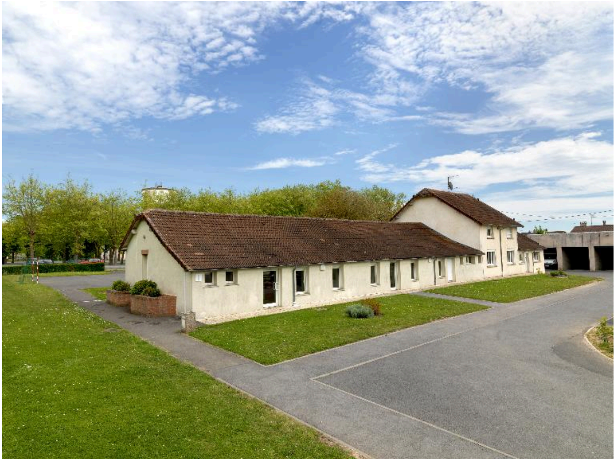
Vue générale depuis le nord-ouest.
