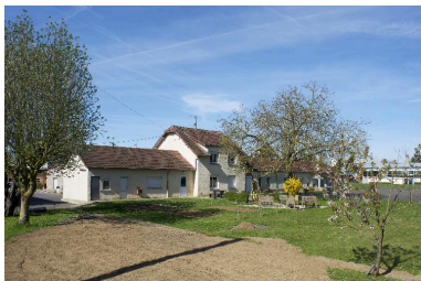
Vue générale depuis le sud-est. Phot. Thierry Lefébure IVR32_20170200155NUC2A
