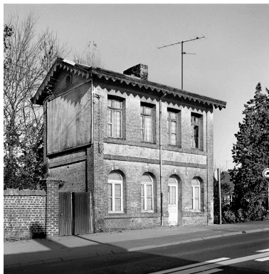
Vue du bureau d'octroi sis au n°645, rue des Docteurs-Deville, construit sur un modèle identique à celui de la rue de Robbé. Phot. Thierry Lefébure IVR22_20020200930X
