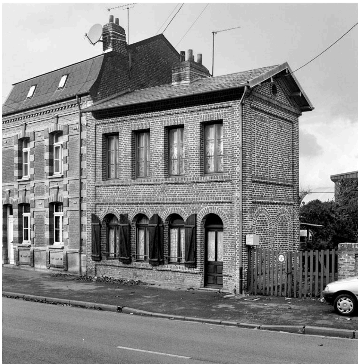
Vue de la façade sur rue du pavillon.
