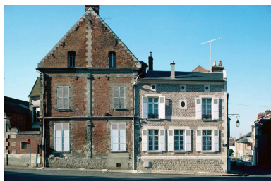
Elévation antérieure. Pignon. Phot. Martine Plouvier IVR22_19856001334ZA
