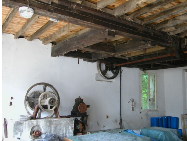
Intérieur du rez-de-chaussée, vue des vestiges des éléments de transmissions. Phot. Bertrand Fournier IVR22_20036000548NUCA
