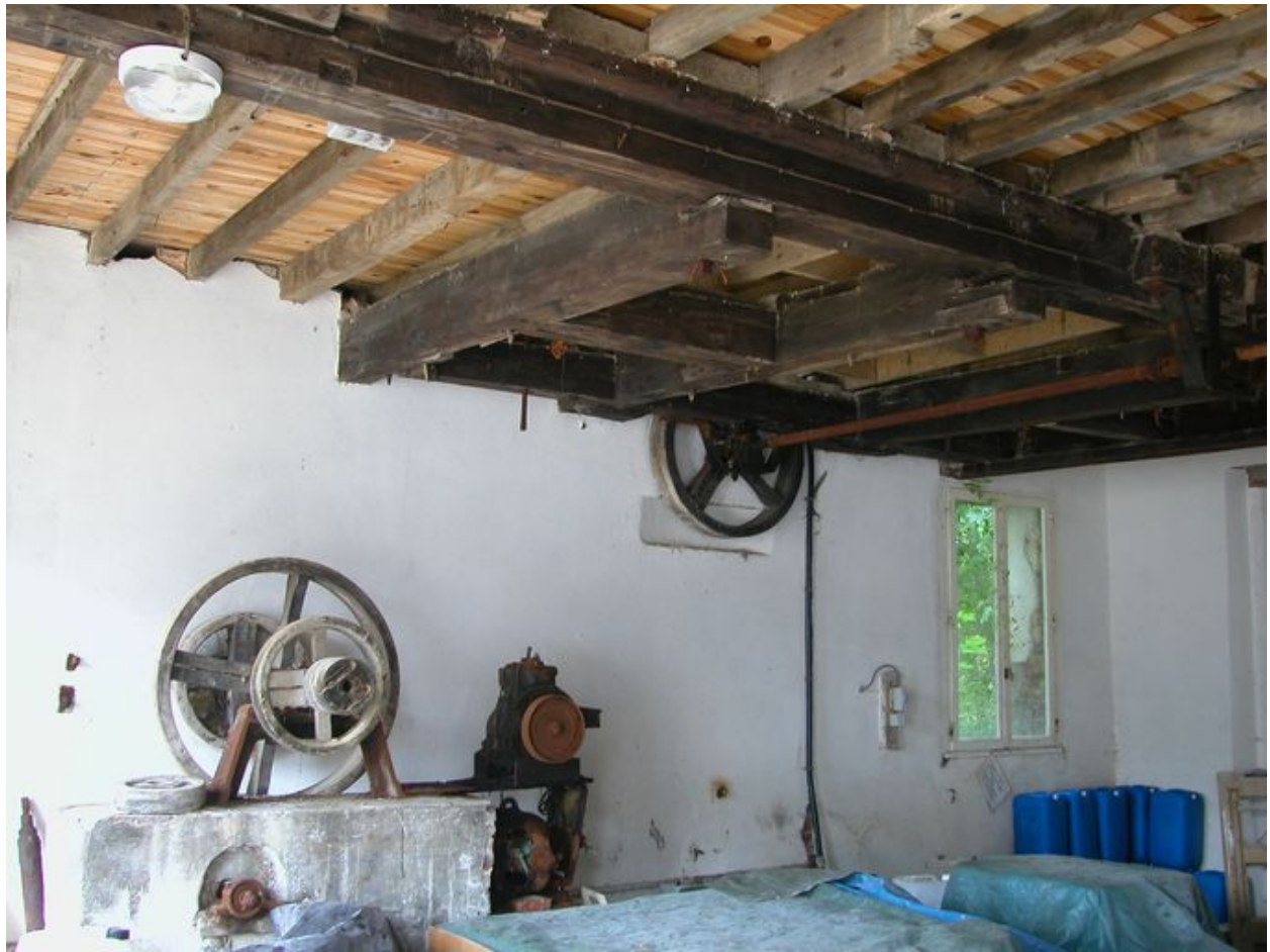
Intérieur du rez-de-chaussée, vue des vestiges des éléments de transmissions.
