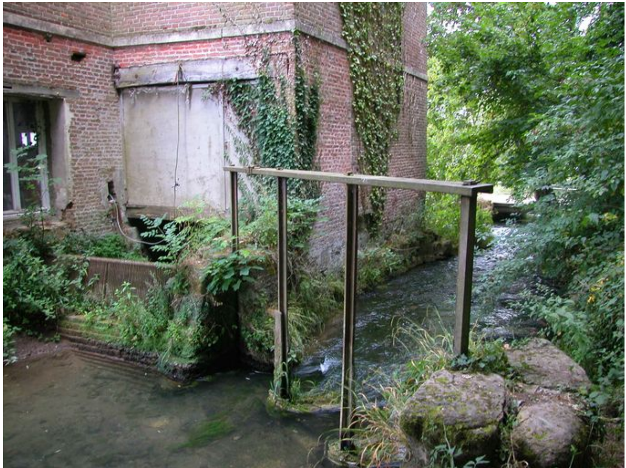
La coulerie et le vannage de décharge.
