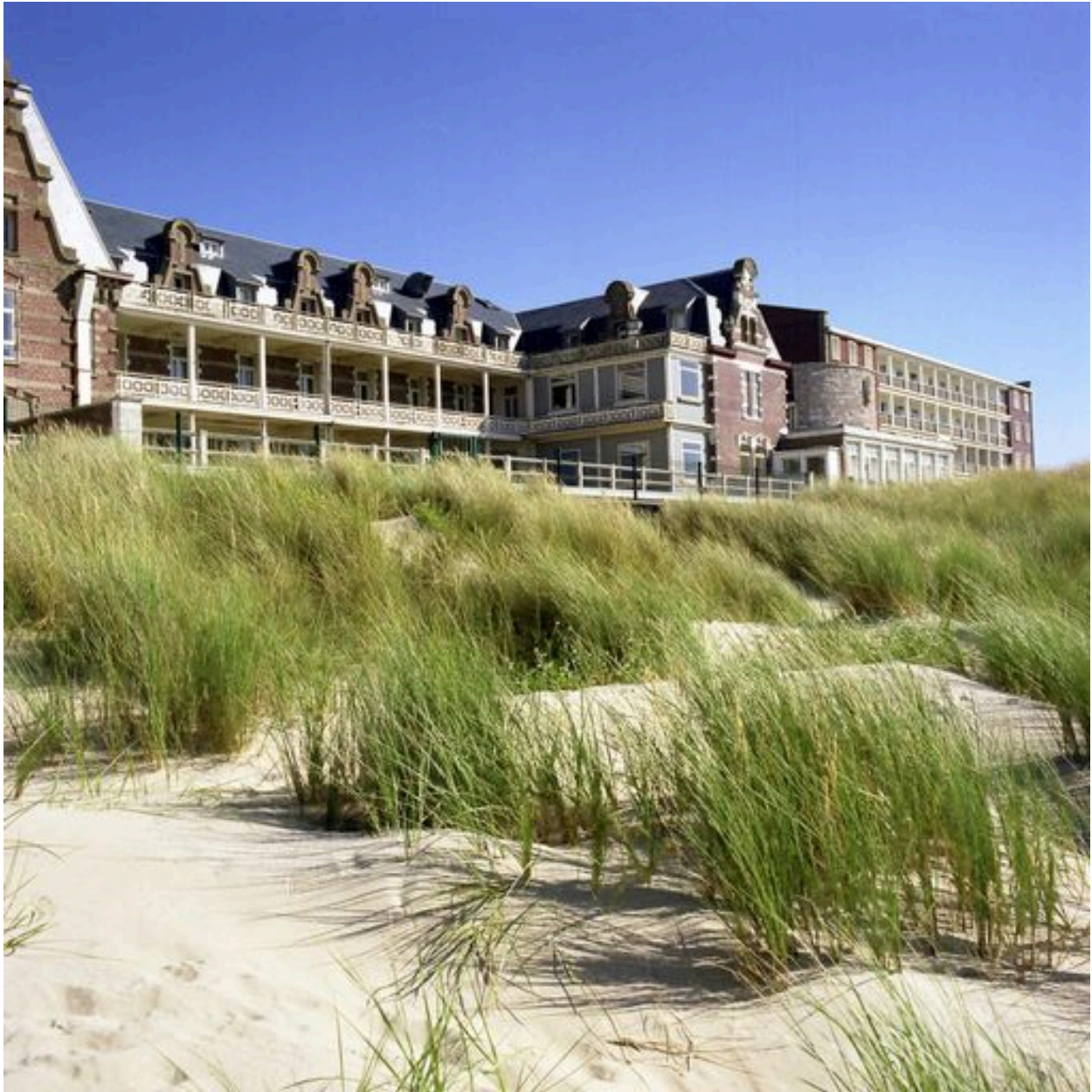
Bâtiment méridional de l'établissement primitif, élévation sur la plage, vue de trois-quarts gauche.
