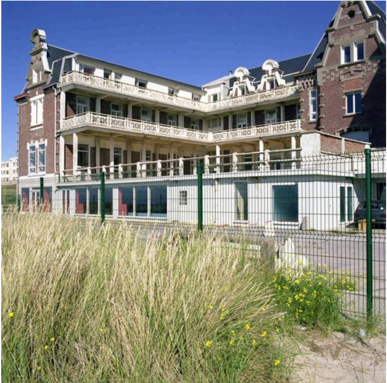
Bâtiment septentrional de l'établissement primitif, élévation sur la plage.
