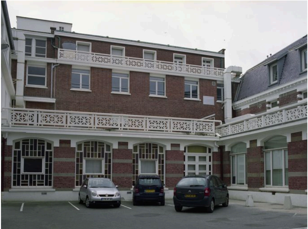
Cour qui s'étend sur l'arrière du bâtiment méridional de l'établissement primitif, vue générale.
