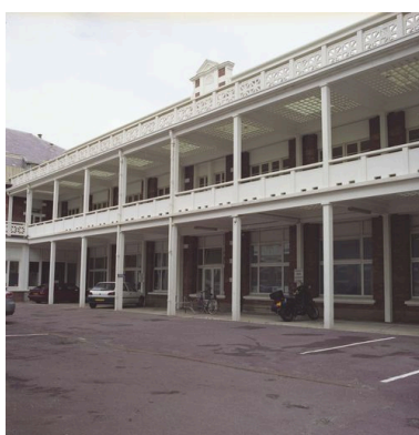
Bâtiment d'hospitalisation ajouté dans l'entre-deux-guerres au nord de l'établissement primitif, élévation sur la cour avec ses galeries de cure d'air superposées, vue de trois-quarts droit. Phot. Pierre Thibaut IVR31_20086200011XE
