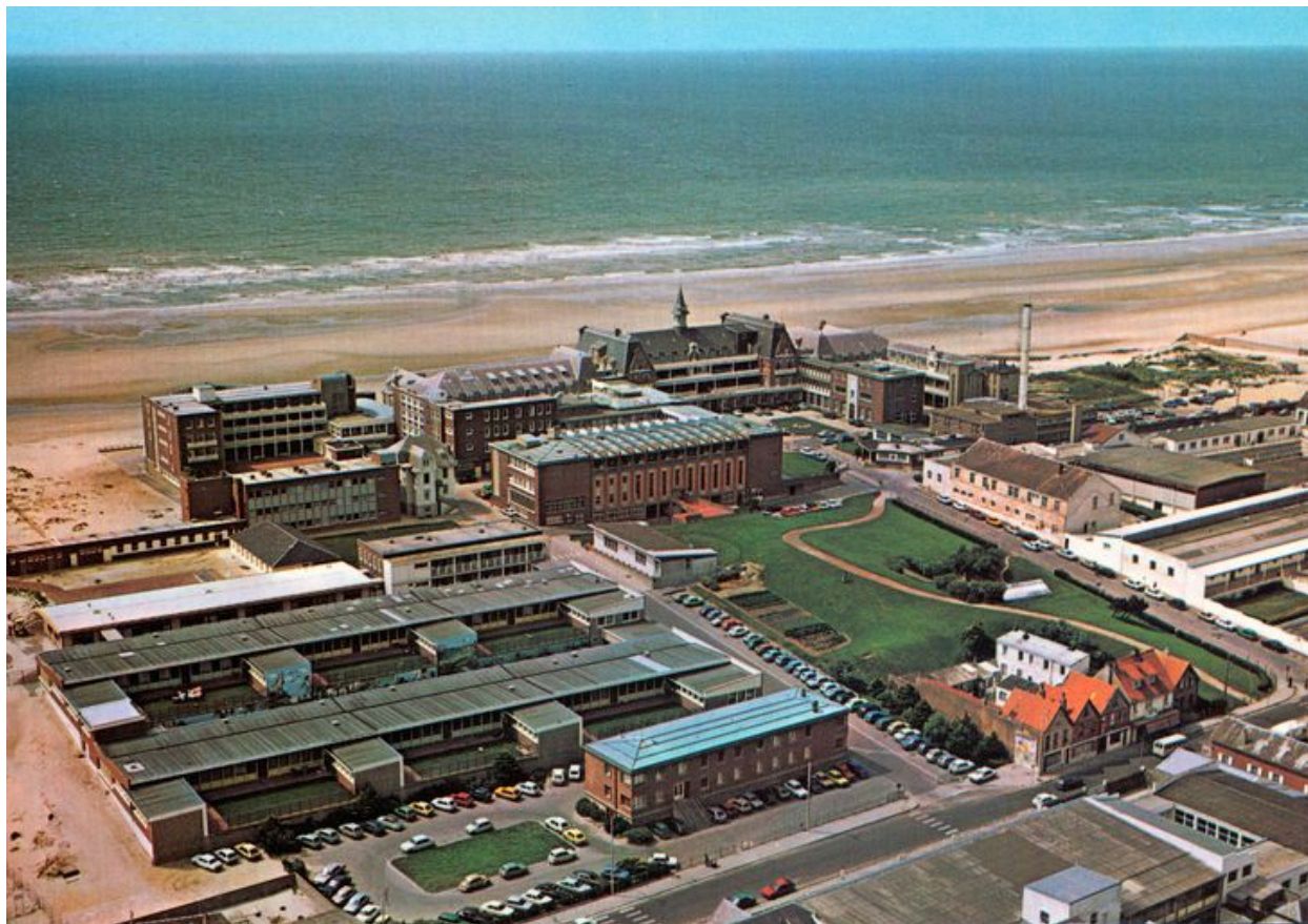
Vue aérienne générale prise du sud-est en regardant vers nord-ouest montrant, au premier plan sur la gauche, les bâtiments ajoutés dans les années 1950 et 1960. Carte postale, vers 1970 (coll. part.).
