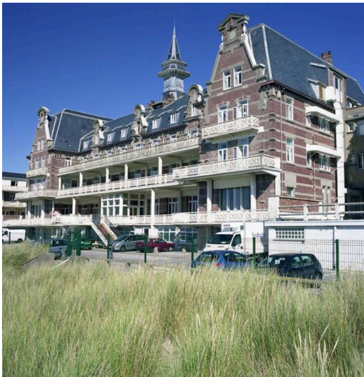
Corps de logis principal de l'établissement primitif, élévation sur la plage, vue prise de trois-quarts droit.
