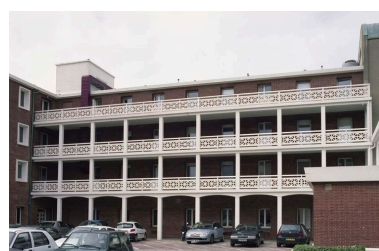
Nouveau bâtiment d'hospitalisation ajouté dans les années 1960 sur le flanc sud de la chapelle, élévation postérieure, vue de trois-quarts droit. Phot. Pierre Thibaut IVR31_20086200016XE
