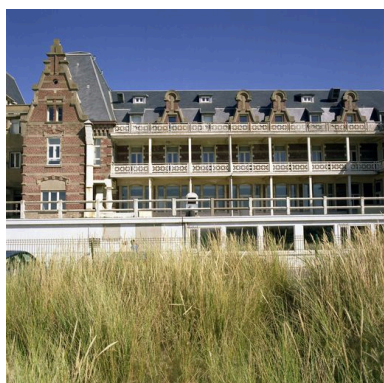
Bâtiment méridional de l'établissement primitif, élévation sur la plage. Phot. Pierre Thibaut IVR31_20096200002XE
