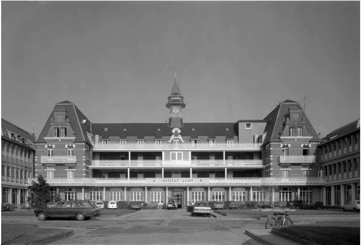
Corps de logis principal, façade sur la cour, vue de face.
