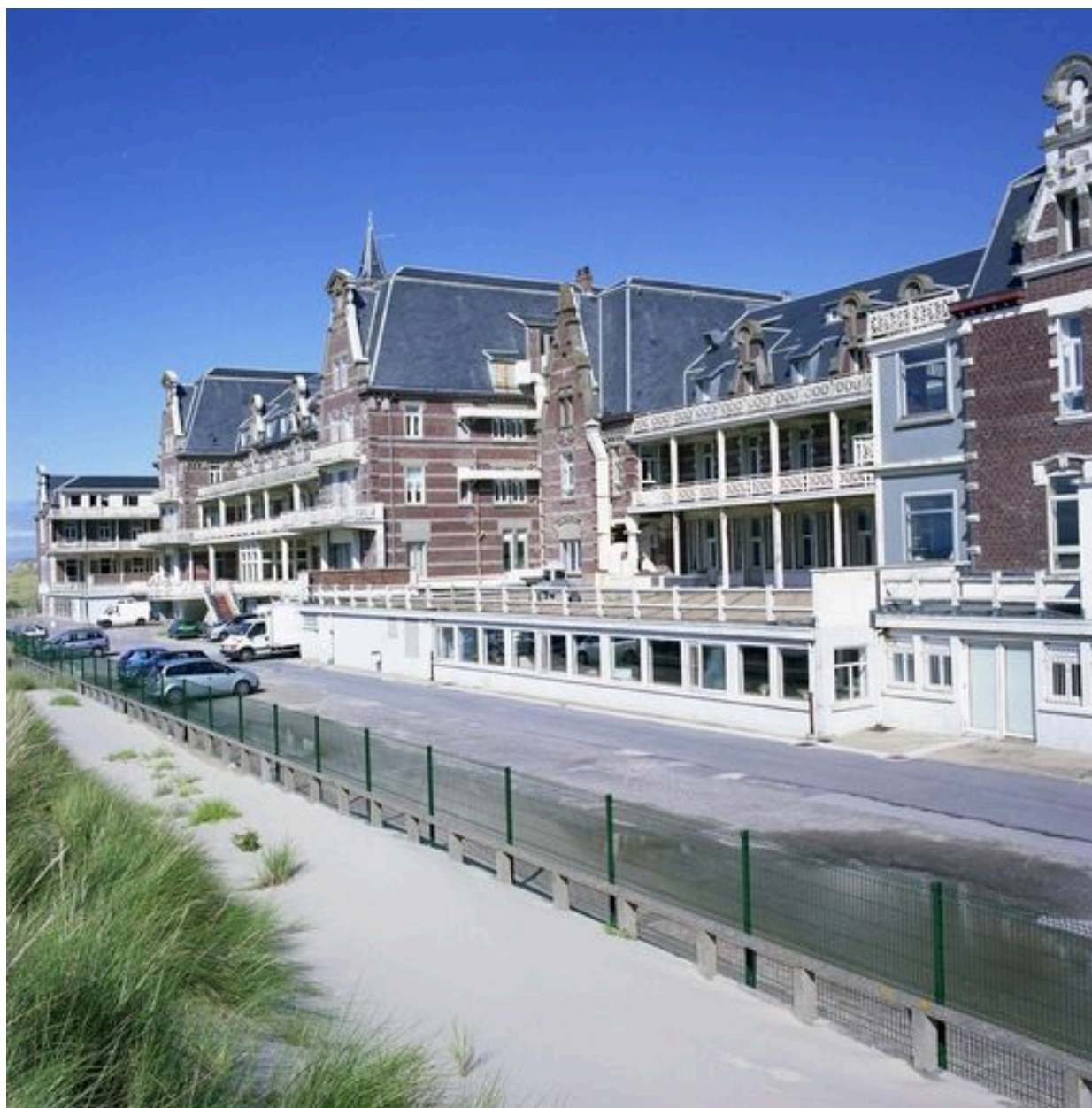
Bâtiments constitutif de l'établissement primitif, élévation sur la plage, vue d'ensemble prise en enfilade depuis le sud.
