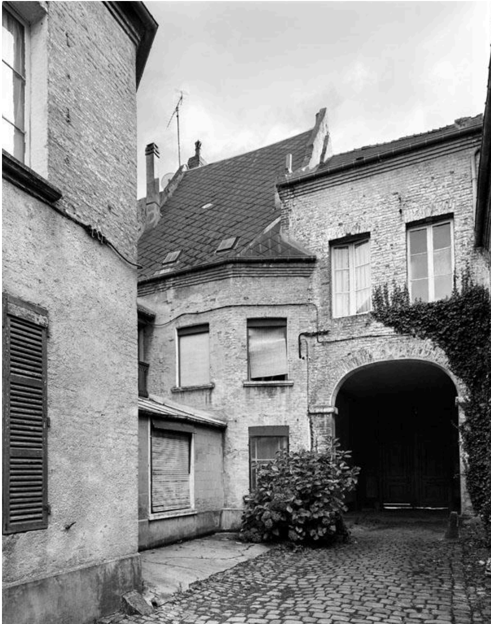
Vue du passage de la porte cochère, depuis la cour intérieure.
