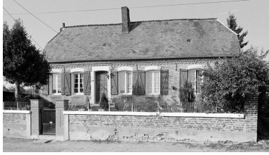
Vue de la façade. Phot. Christiane Riboulleau IVR22_19940201466Z
